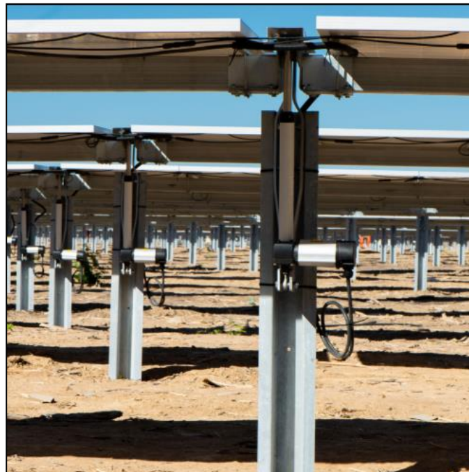
Figura n.32 – Rappresentazione della struttura di supporto vista posteriore
