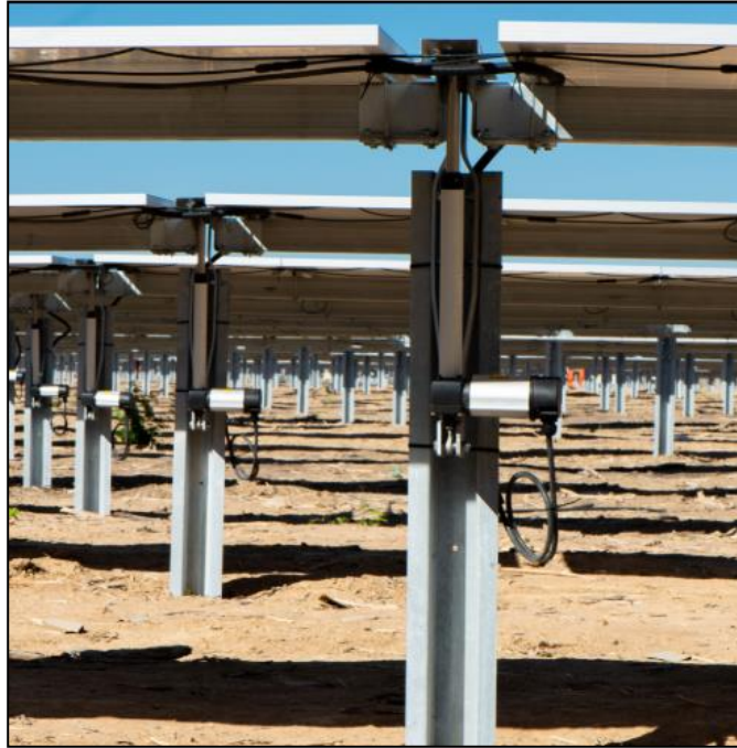
Figura n.5 – Rappresentazione della struttura di supporto vista posteriore
