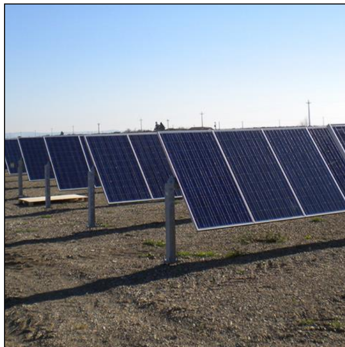
Figura n.4 – Rappresentazione della struttura di supporto vista frontale
