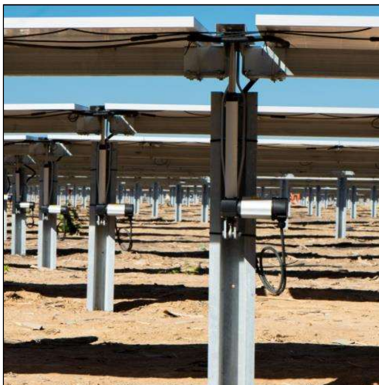
Figura 5 – Rappresentazione della struttura di supporto vista posteriore
