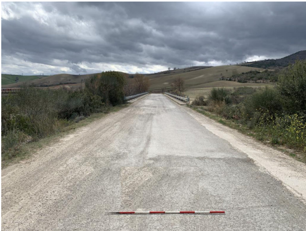
FOTO 8: CAVIDOTTO IN USCITA DA SSE, SUPERAMENTO PONTE SALANDRELLA.VISTA DA NE.
