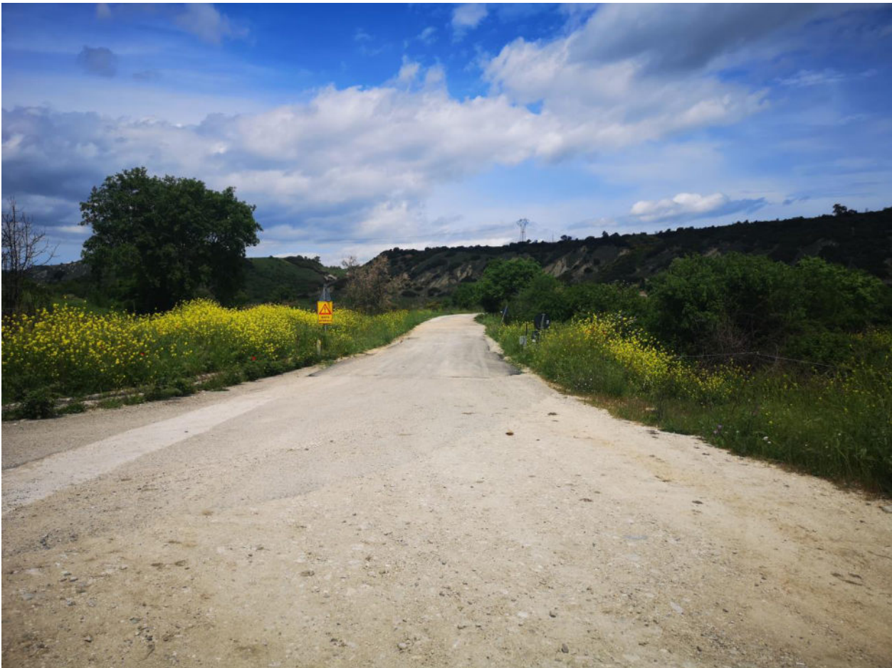
FOTO 5: CAVIDOTTO IN USCITA DALLA SSE, VISTA DA S-S/E.
