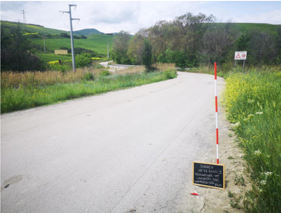
FOTO 14: CAVIDOTTO LUNGO SP4. VISTA DA NE.
