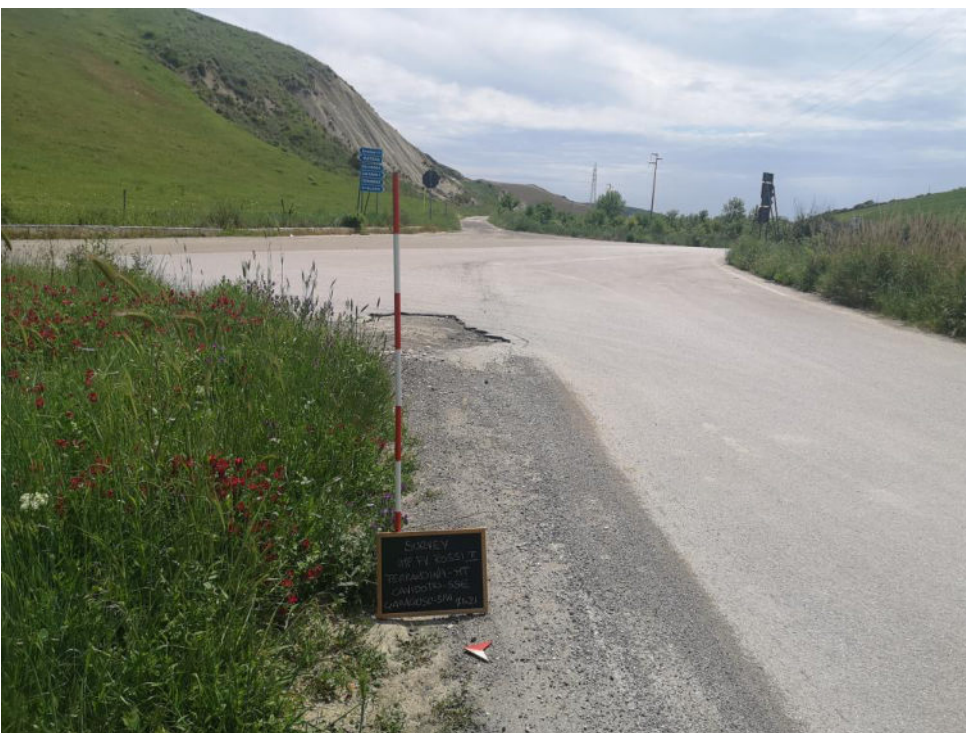
FOTO 15: CAVIDOTTO LUNGO SP4. VISTA DA W.
