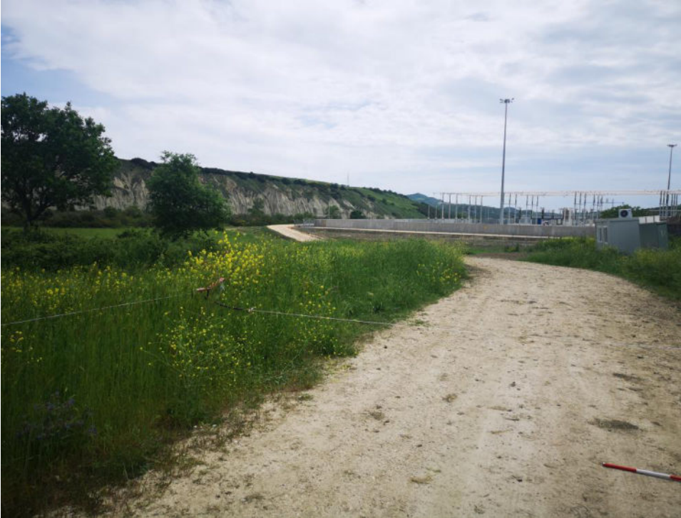
FOTO 6: CAVIDOTTO IN USCITA DALLA SSE, VISTA DA N.
