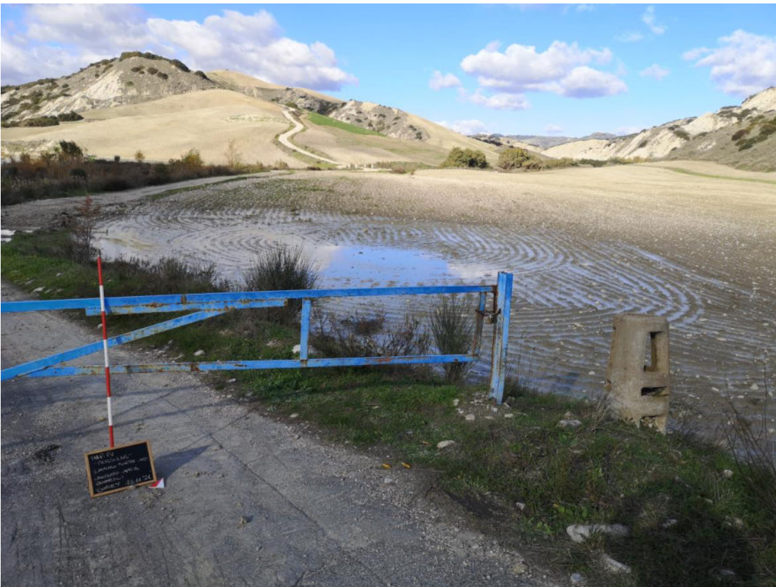
FOTO 21: CAVIDOTTO IMMISSIONE DA SP 4 VERSO AREA IMPIANTO.
