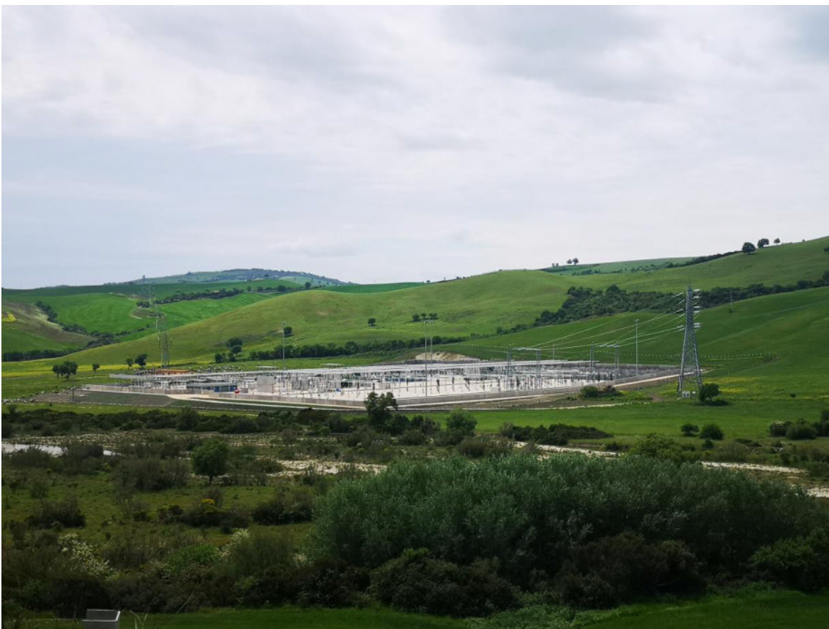
FOTO 10-11: PANORAMICA, DAL CAVIDOTTO, DELLA STAZIONE TERNA (REALIZZATA NEL 2020) E DELLE CABINE DI CONSEGNA. VISTA DA NE.
