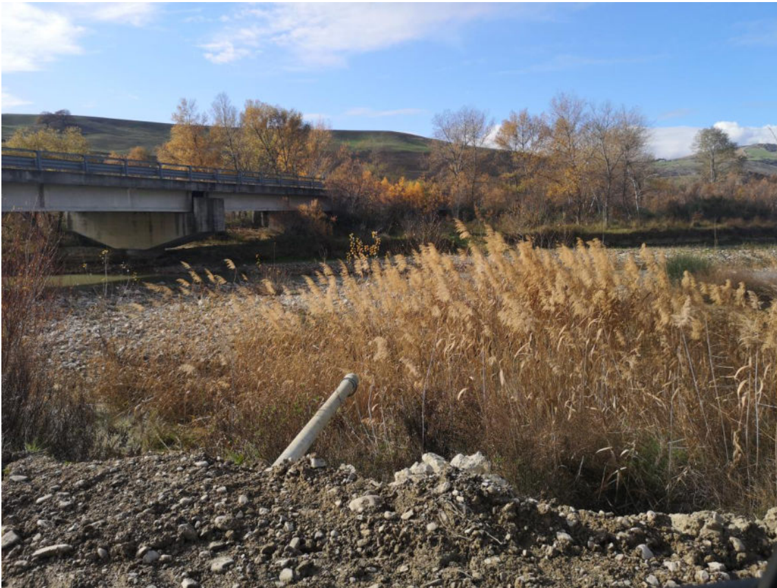
FOTO 22: CAVIDOTTO IMMISSIONE DA SP 4 VERSO AREA IMPIANTO.
