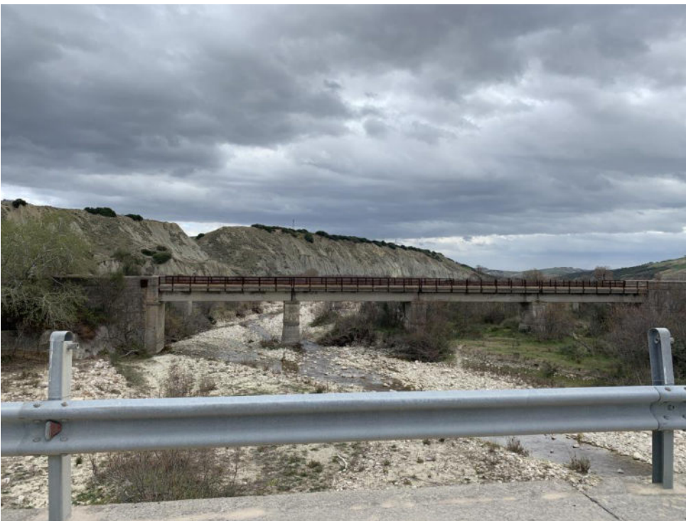
FOTO 7: CAVIDOTTO IN USCITA DALLA SSE, ATTRAVERSAMENTO SALANDRELLA.
