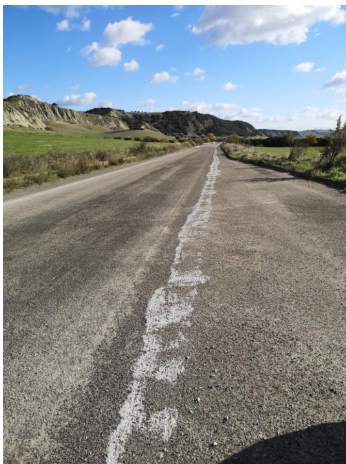
FOTO 17: CAVIDOTTO LUNGO SP4.
