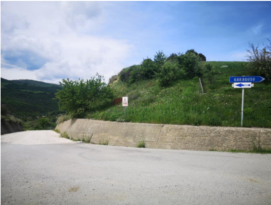
FOTO 12: CAVIDOTTO, IMMISSIONE SU SP4. VISTA DA S.
