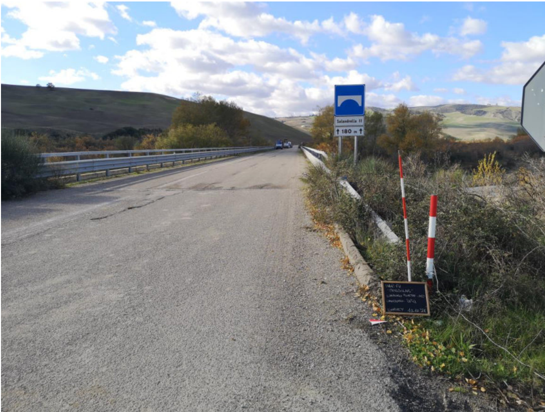
FOTO 18: CAVIDOTTO LUNGO SP4. VERSO AREA IMPIANTO. VISTA DA NW.
