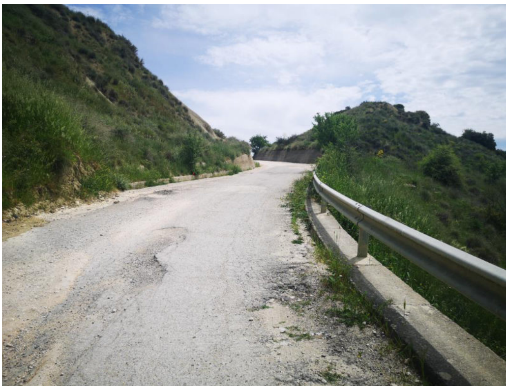
FOTO 9: CAVIDOTTO, INTERSEZIONE CON IL TRATTURO VINCOLATO N.52 (TRASFORMATO E INGLOBATO NELLA VIABILITÀ MODERNA S.C. SENZA NOME, DIRAMAZIONE DA SP4). VISTA DA W.
