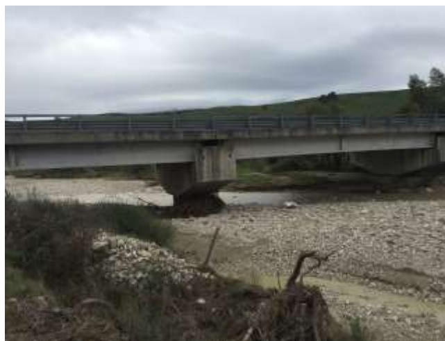
Figura 8: attraversamento n. 6 SP4 con Torrente Salandrella
