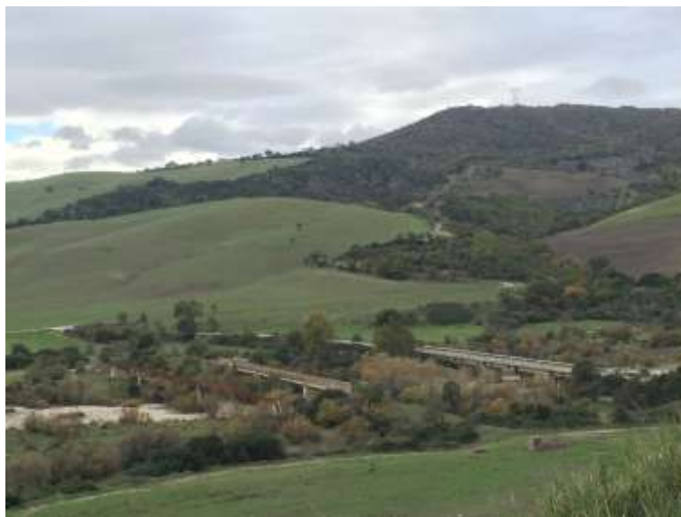
Figura 24: attraversamento 1 - torrente Salandrella – panoramica dalla sponda in sinistra idraulica – da valle verso monte si individuano il ponte canale, il ponte carrabile dismesso e il ponte carrabile in uso.
