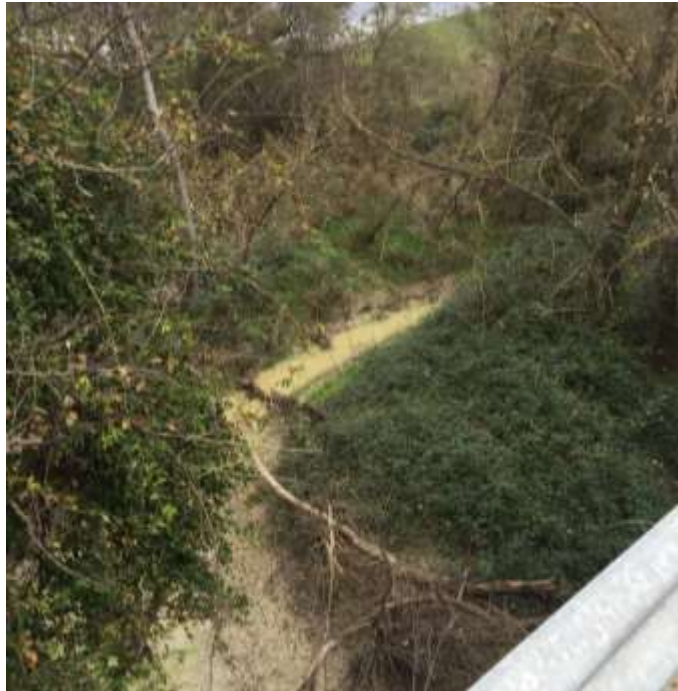
Figura 16: attraversamento 2 – vista da valle verso monte – tratto inciso
