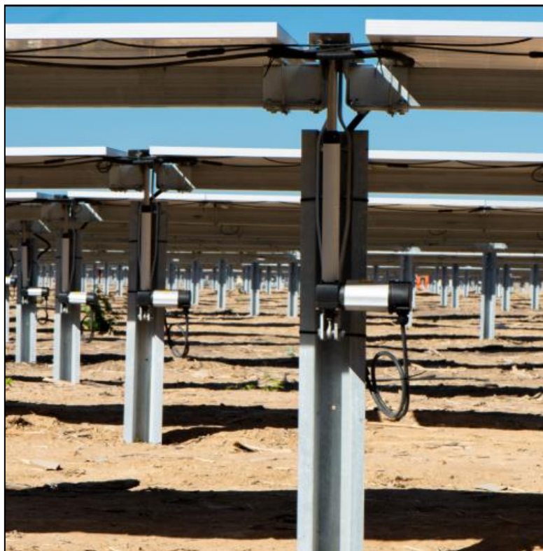
Figura 19 – Rappresentazione della struttura di supporto vista posteriore
