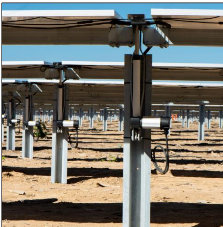
Figura 5 – Rappresentazione della struttura di supporto vista posteriore
