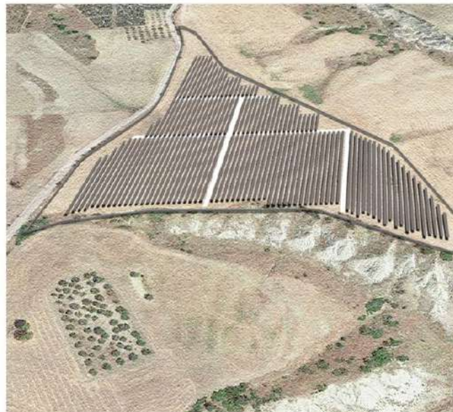
VISTA DA NORD
