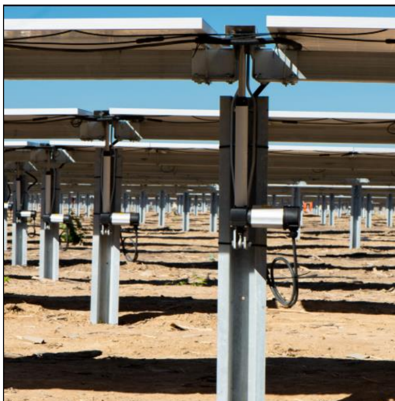
Figura 6 – Rappresentazione della struttura di supporto vista posteriore
