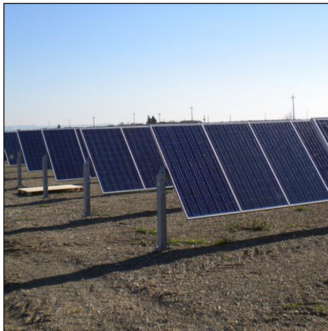
Figura 5 – Rappresentazione della struttura di supporto vista frontale
