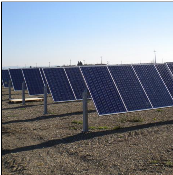
Figura 1 – Rappresentazione della struttura di supporto vista frontale
