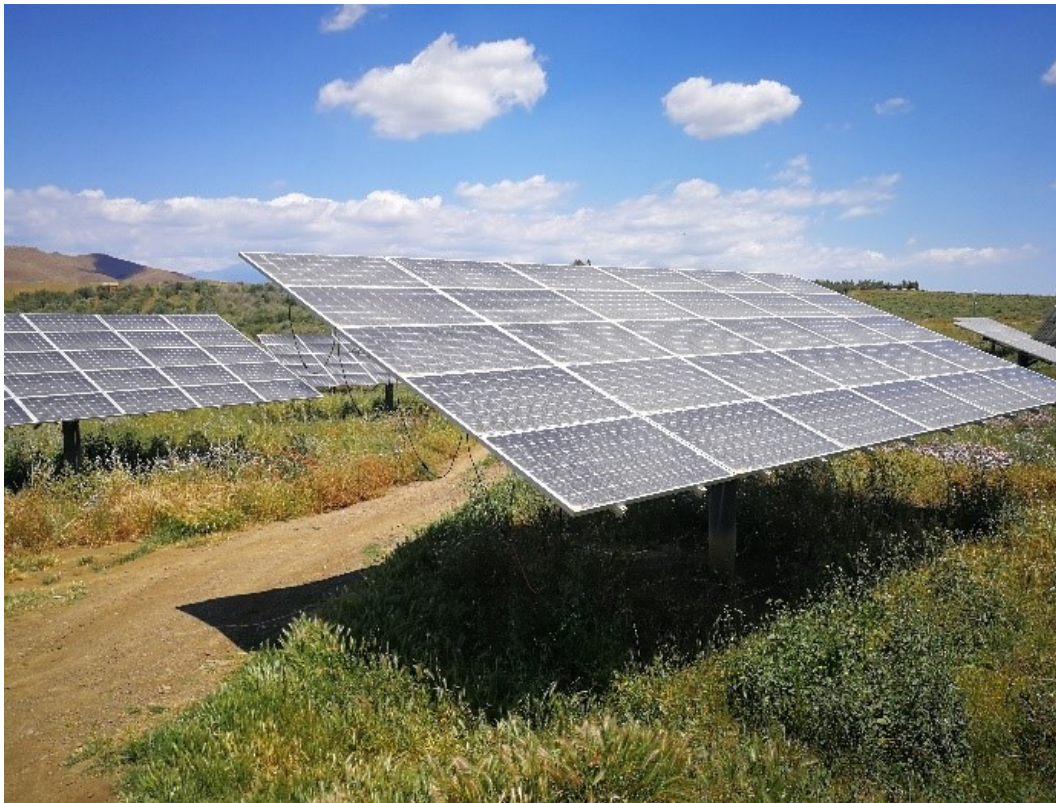
Figura 6 - Inseguitore biassiale "azimut-elevazione"
