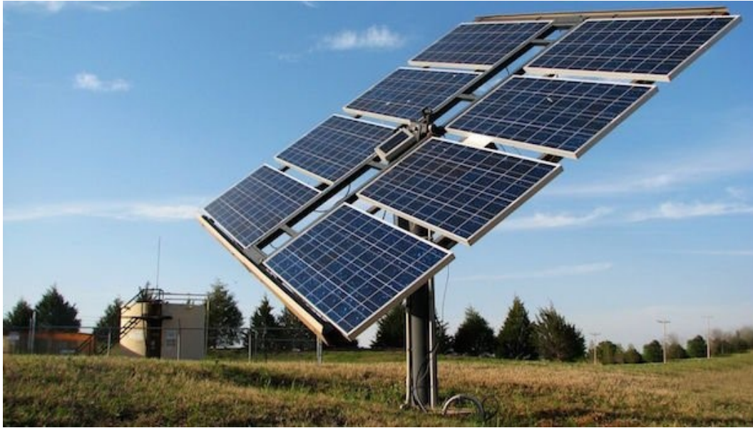
Figura 41 - Inseguitori monoassiali di "azimut"
