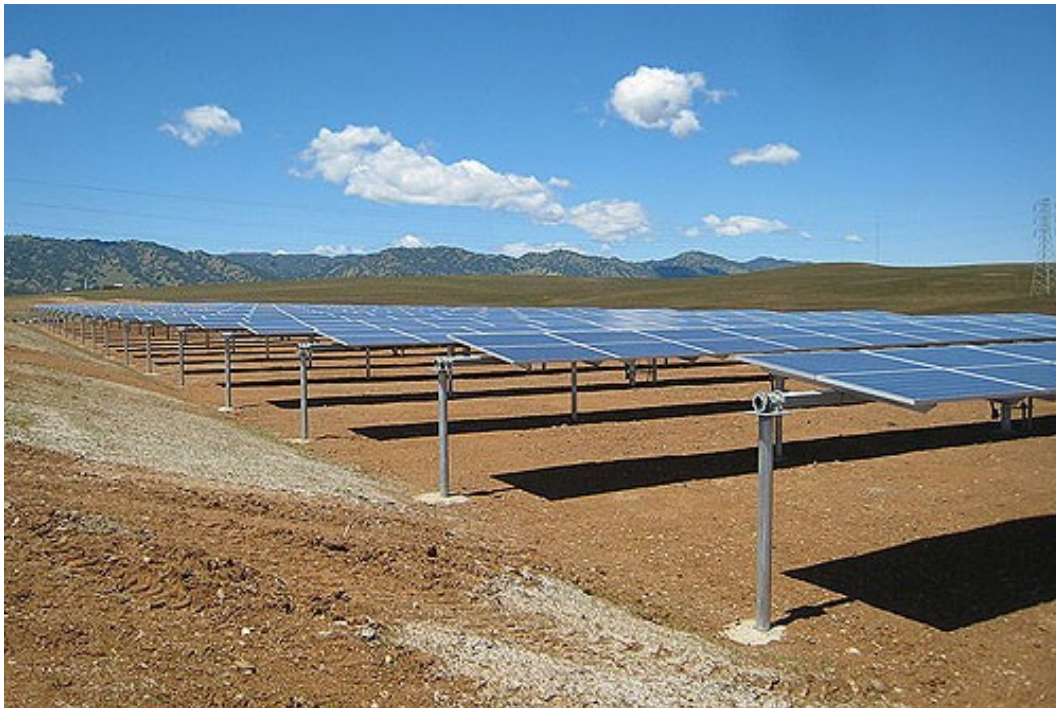
Figura 3 - Inseguitori monoassiali di "rollio"
