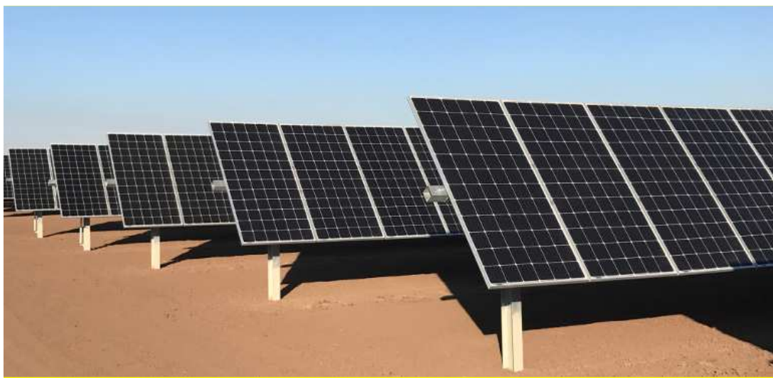
Strutture di supporto "Tracker mono-assiale"
