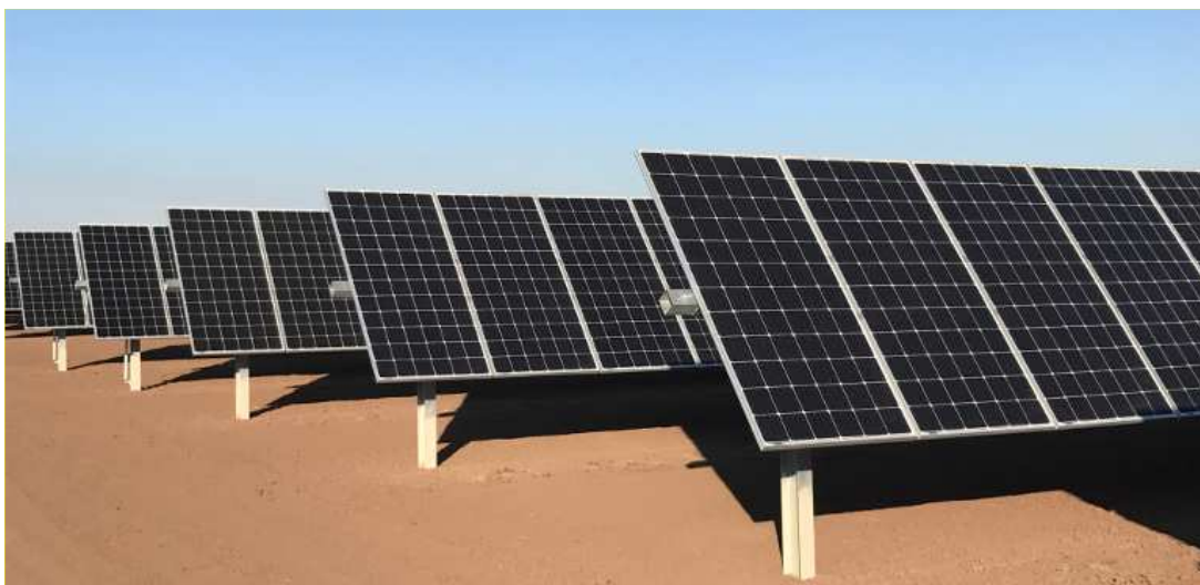
Strutture di supporto "Tracker mono-assiale"
