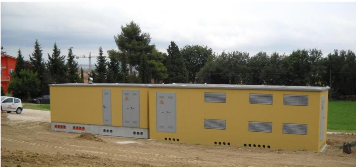
La cabina di campo **tipo b** sarà costituita da 1 vano utente BT e 1 vano per TRAFI MT/BT 20/0,4 kV 2,20 MVA, con dimensioni pari a 6,70 m x 2,50 m ed altezza fuori terra pari a 2,60 m, realizzate in c.a.v. prefabbricato, componendosi di 2 elementi monolitici ovvero la vasca, che svolge la doppia funzione di fondazione e di alloggio dei cavi in arrivo o in partenza dal campo, e il corpo in elevazione. Gli elementi della
