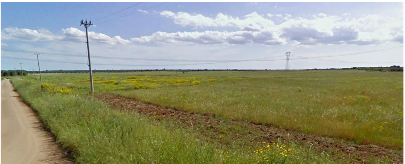
Figura 4-2: Vista a Nord-est dell'impianto
