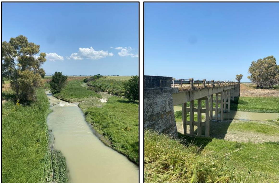
Foto 41 – 42: Attraversamento del cavidotto esterno in corrispondenza del Torrente Cervaro
