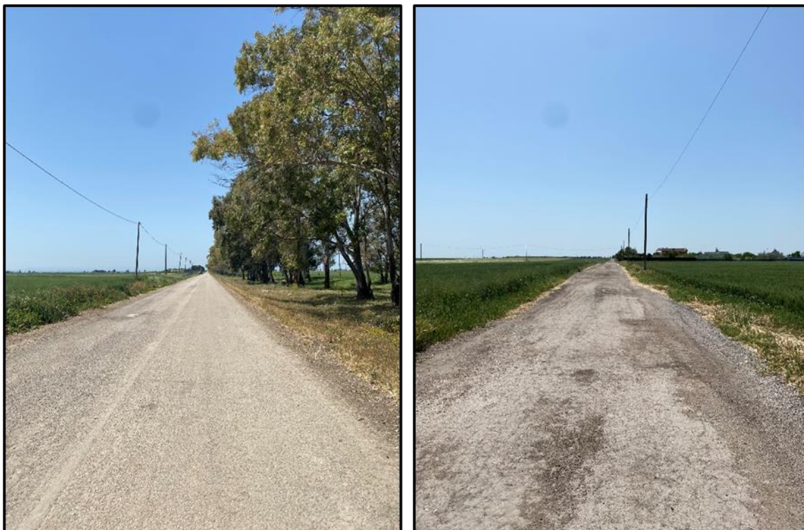
Foto 39 – 40: Viabilità stradale (SP 70) e poderale che sarà percorsa dal cavidotto esterno
