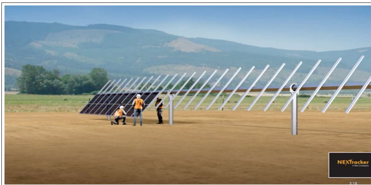
Figura 7-1 Particolare Tracker Horizon-NX Gemini
