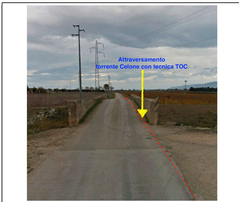
Figura 3-3 Attraversamento cavidotto MT 30 kV del torrente CELONE
