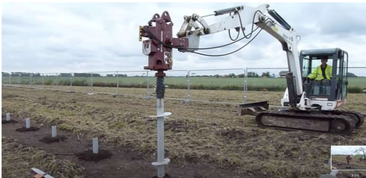
Figura 70-3 Macchina Operatrice per fissaggio supporti strutture
