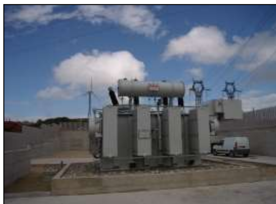
Figura 0-8 Trasformatore MT/AT
