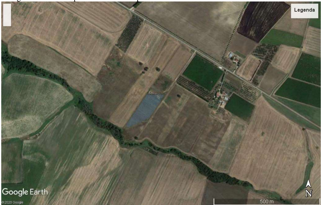
Esempio 3 da 500 metri di altezza – Molise
