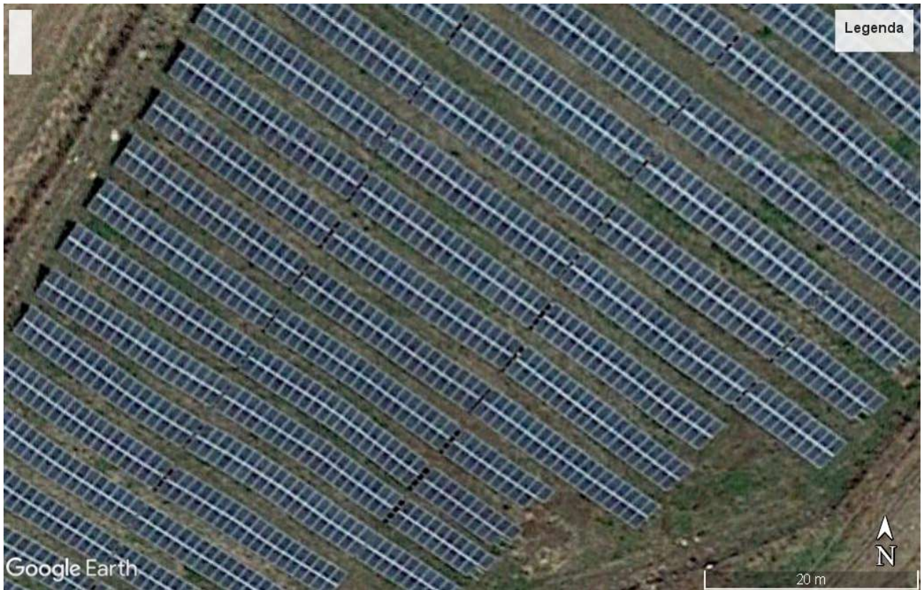
Esempio 3 da 20 metri di altezza - Molise
