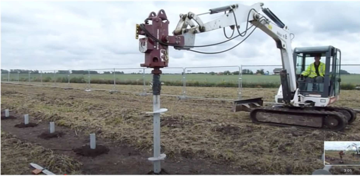
Figura 2-5 Macchina Operatrice per fissaggio supporti strutture
