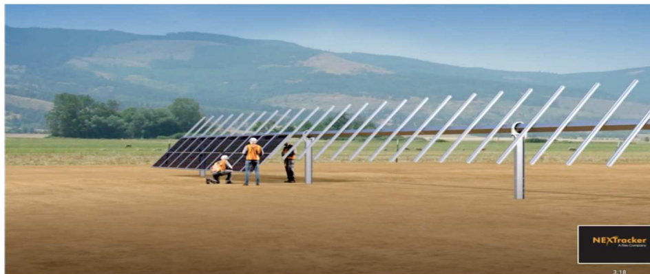
Figura 2-3 Particolare Tracker Horizon-NX Gemin
