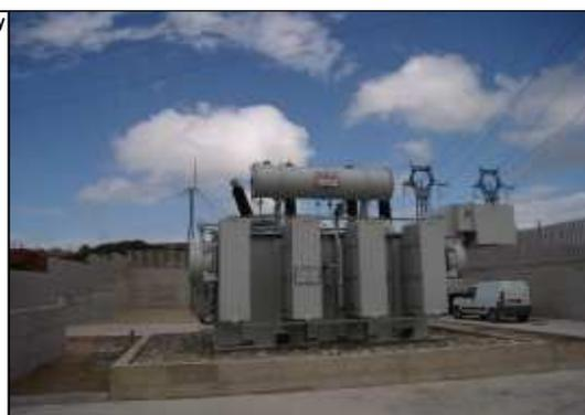
Figura 8-2 Trasformatore MT/AT
