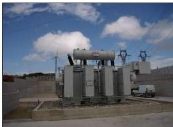
**Figura 3-8 Trasformatore MT/AT**
