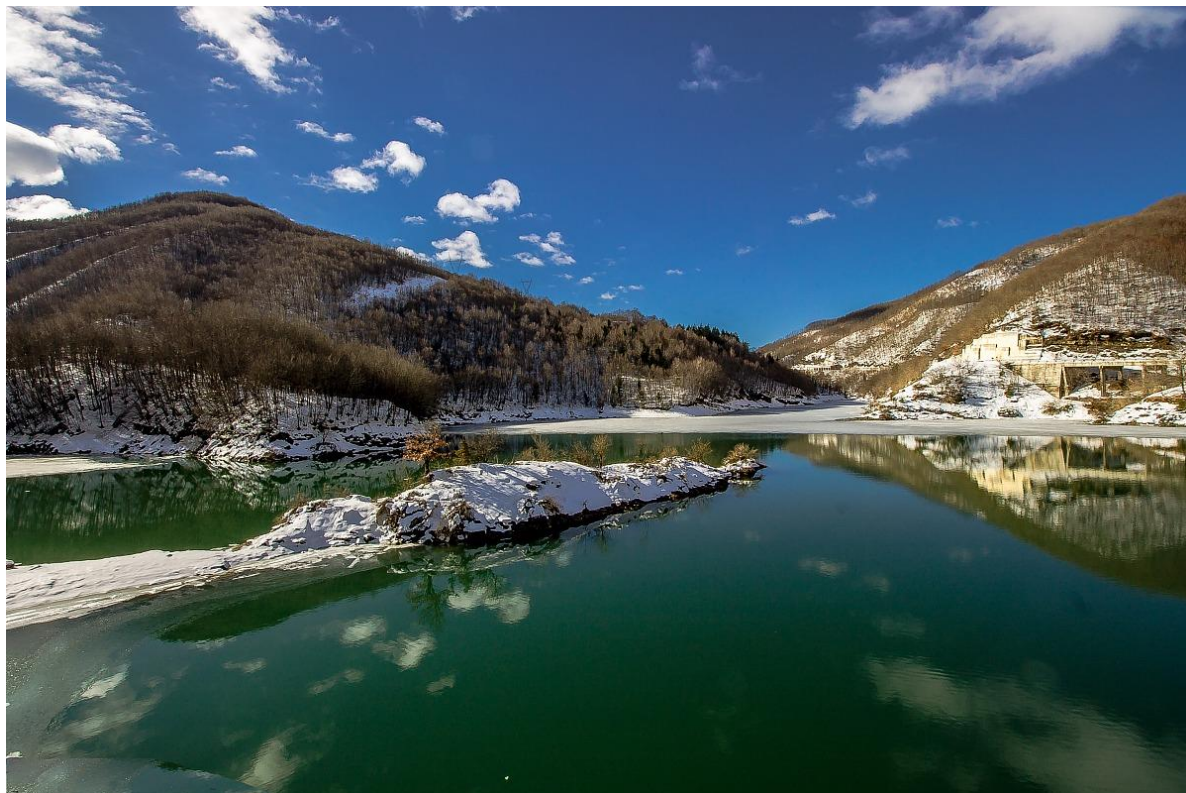
Figura 21: Serbatoio di Provvidenza.
