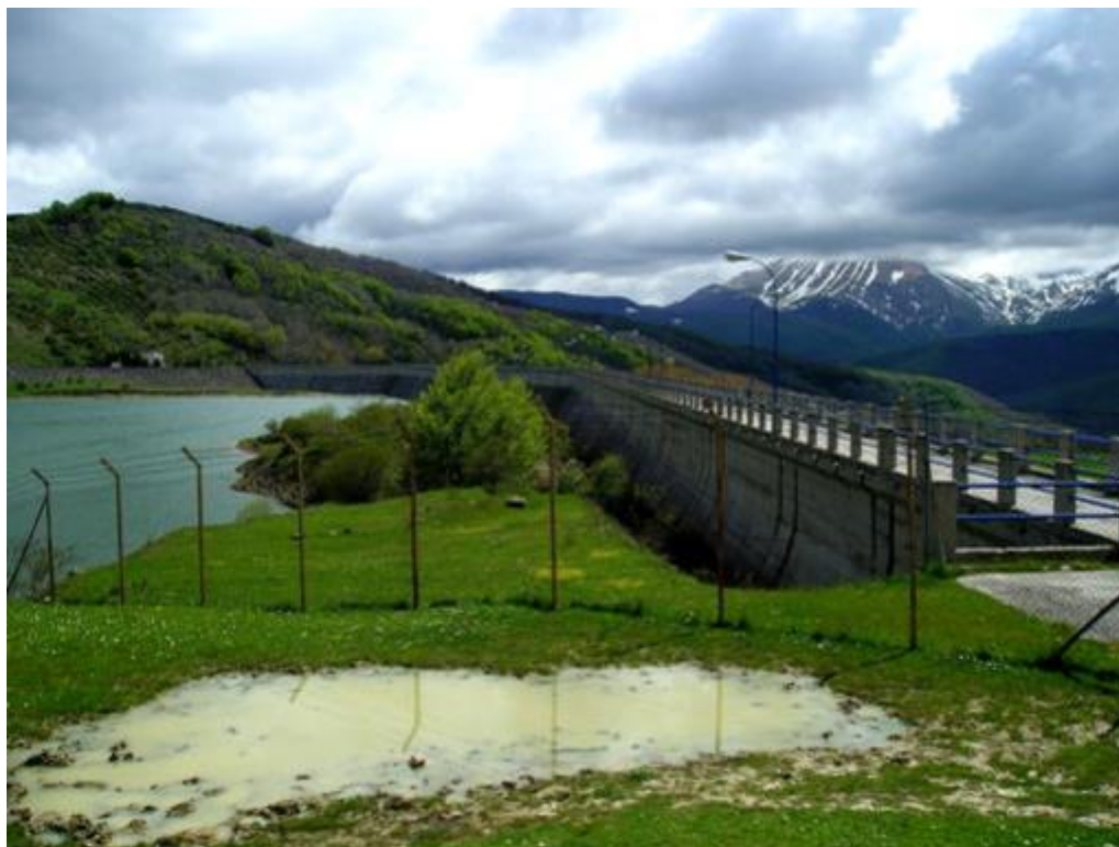
Figura 15: Diga di Sella Pedicate - vista da monte.
