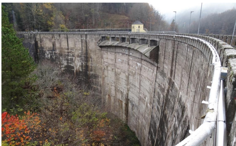
Figura 26: Diga di Provvidenza - vista da valle.
