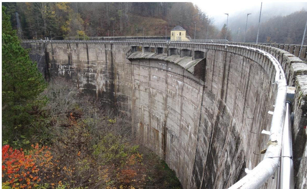
Figura 8: Diga di Provvidenza – vista da valle.
