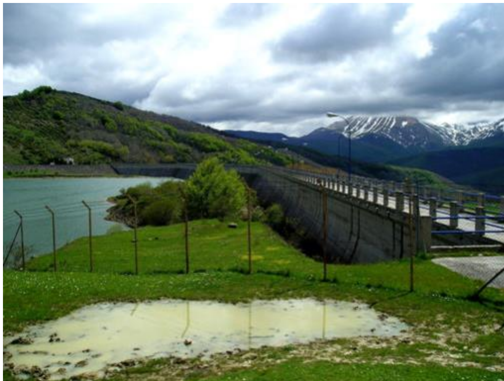
Figura 7: Diga di Sella Pedicate - vista da monte.
