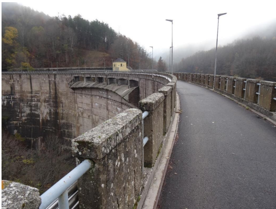
Figura 5: Diga di Provvidenza –coronamento
