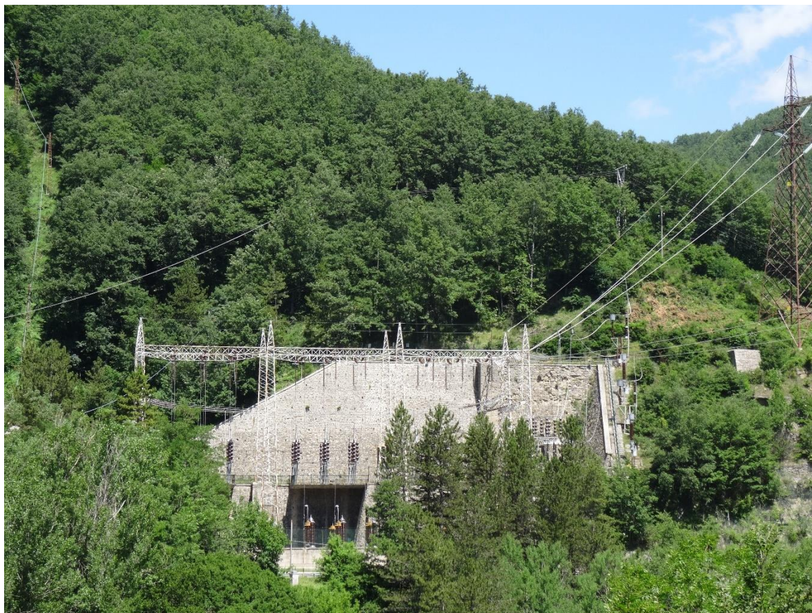
Figura 21: Centrale di Provvidenza - sottostazione
