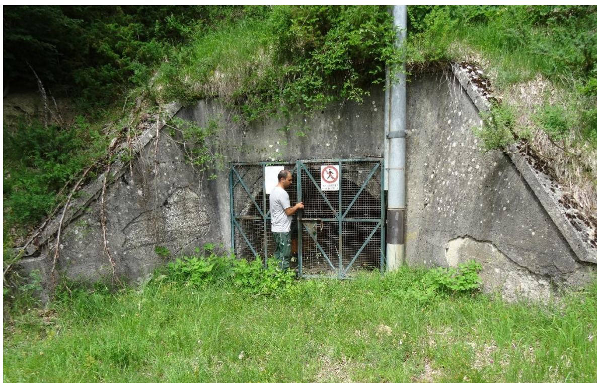
Figura 13: Finestra di accesso alla galleria di adduzione
