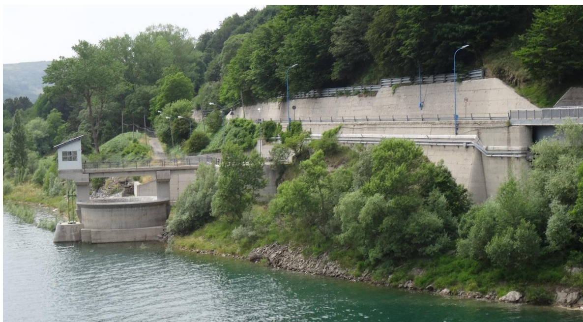
Figura 2: Diga Rio Fucino – sfioratore a calice
