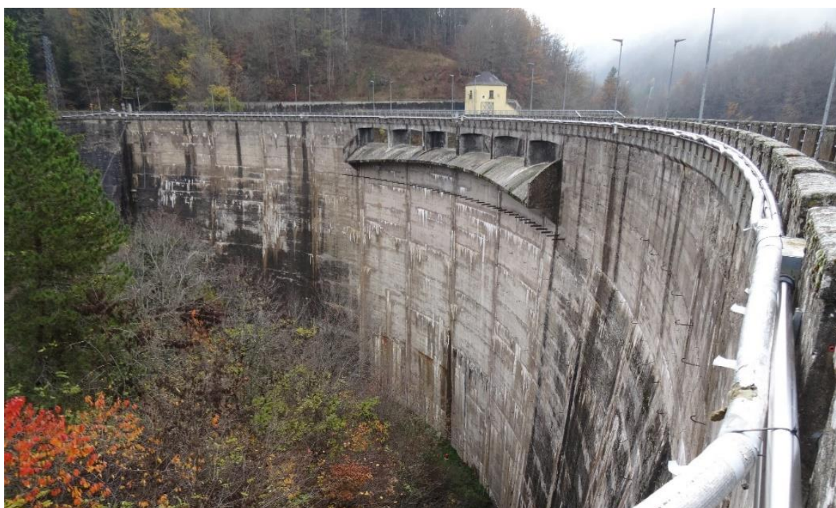
Figura 4: Diga di Provvidenza – Vista da valle
