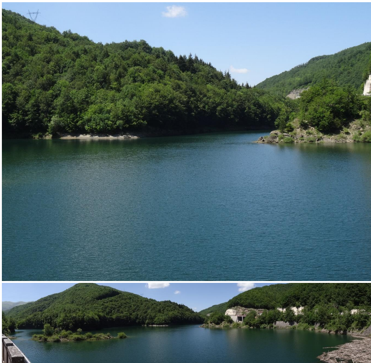
Figura 7: Diga di Provvidenza – invaso
