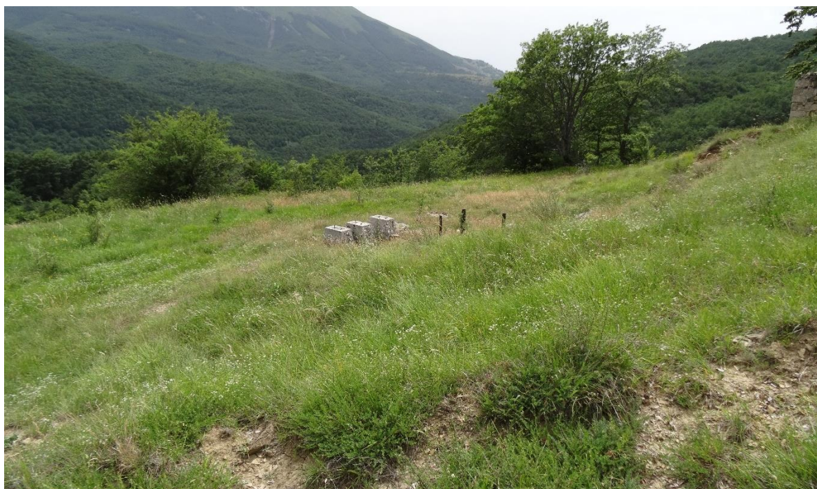
Figura 11: Pozzo Piezometrico e finestra di accesso - pianoro con vecchia area di cantiere e strutture abbandonate
