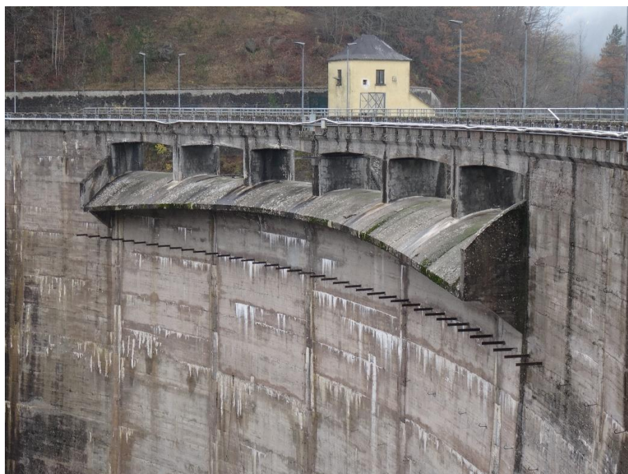
Figura 6: Diga di Provvidenza – Scarico di superficie
