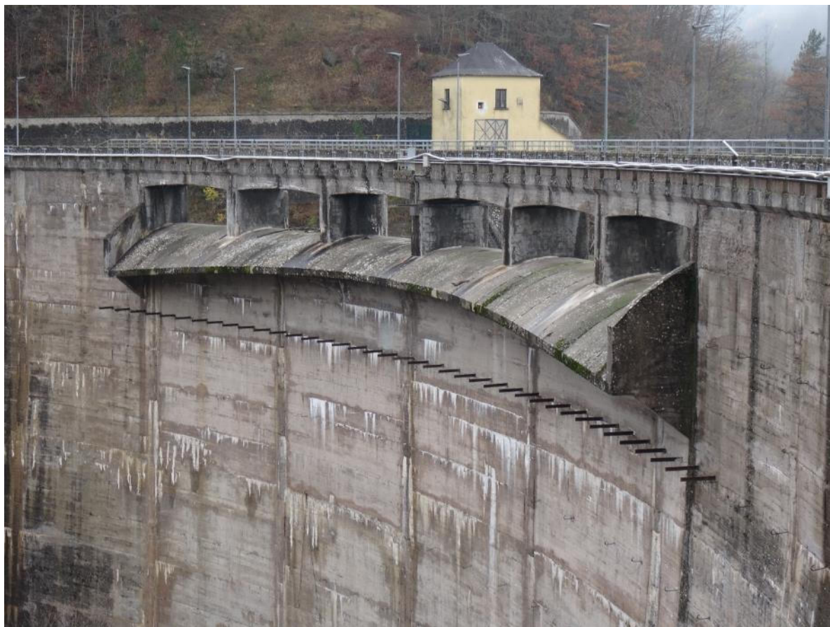
Figura 4: Diga di Provvidenza
