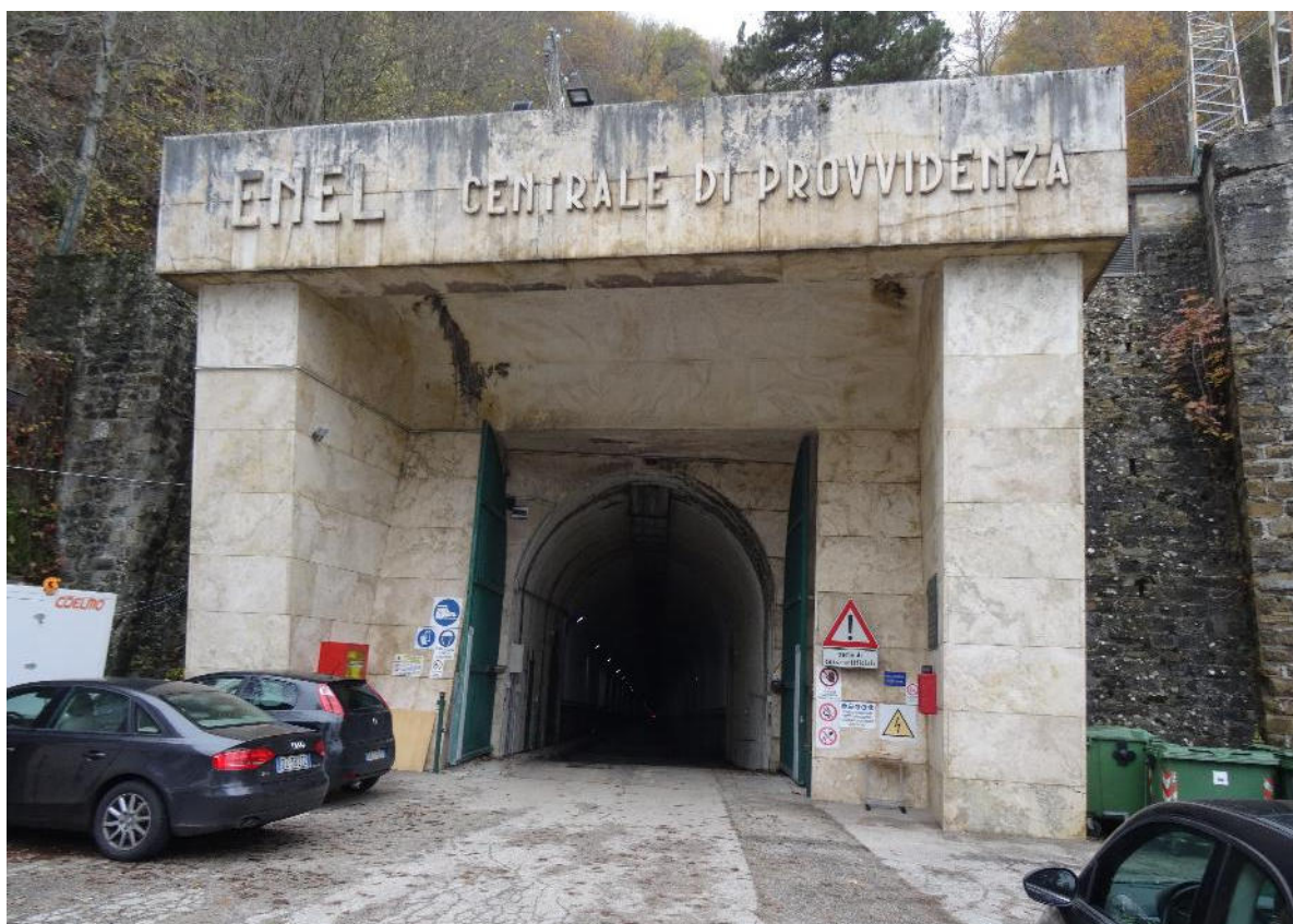
Figura 8: Piazzale di ingresso all'esistente centrale di Provvidenza
