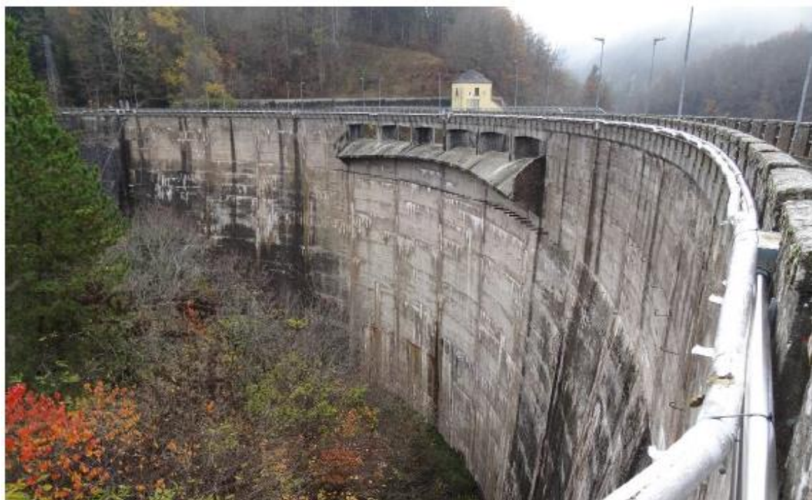
Figura 8: Diga di Provvidenza- vista da valle
