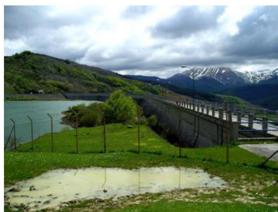
Figura 6: Diga di Sella Pedicate – vista da monte
