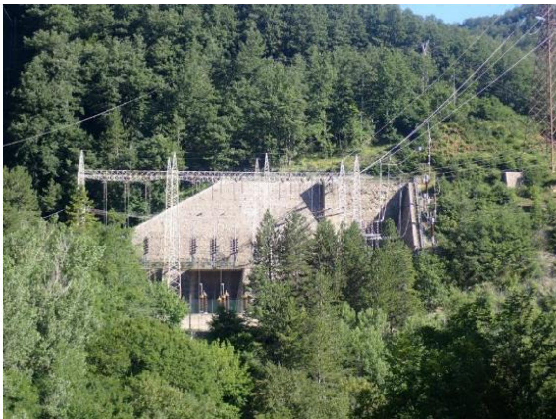
Figura 77: Versante a monte della centrale di Providenza con diffusa presenza di conifere
