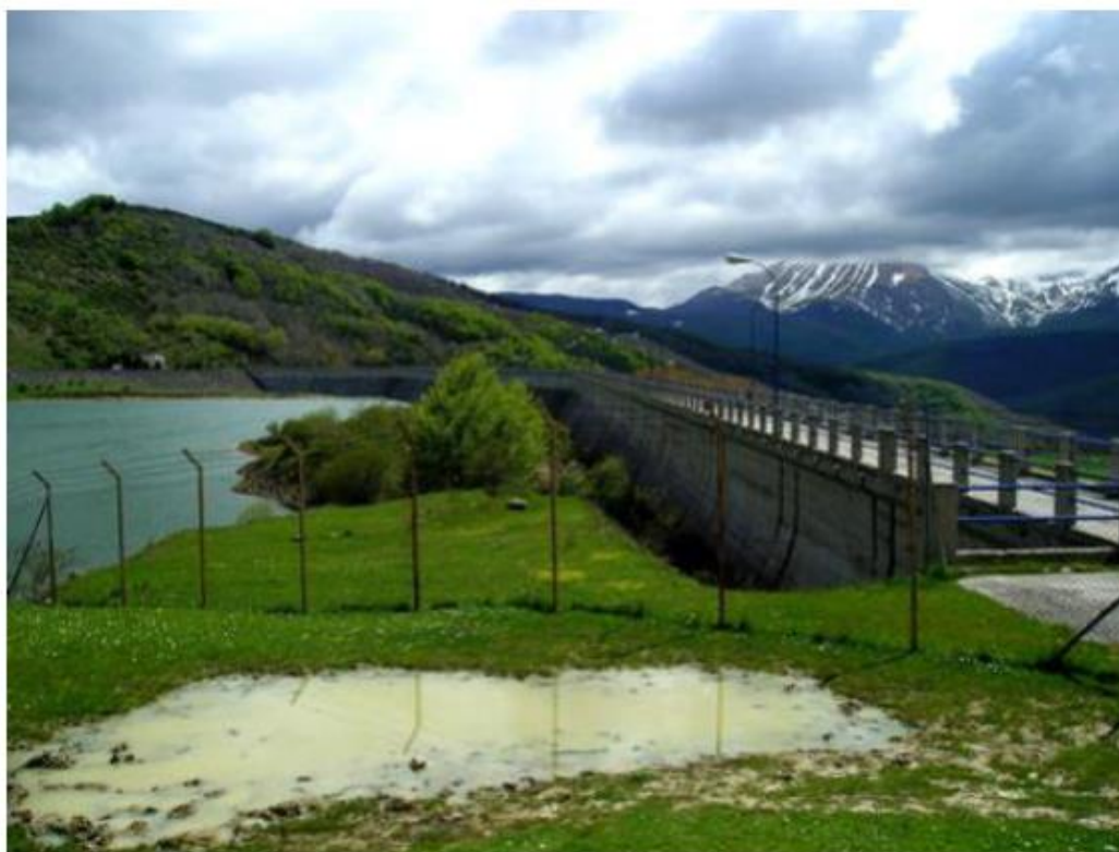
Figura 11: Diga di Sella Pedicate – vista da monte
