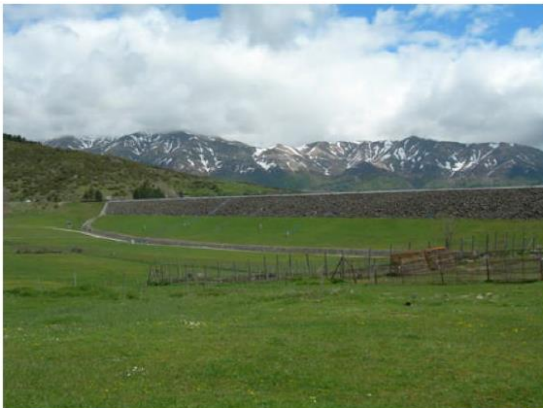
Figura 9: Diga di Poggio Cancelli – vista da valle
