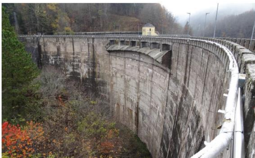
Figura 12: Diga di Provvidenza- vista da valle
