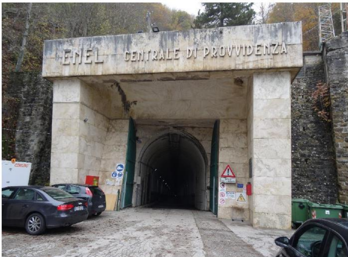
Figura 61: Piazzale di ingresso all'esistente centrale di Provvidenza
