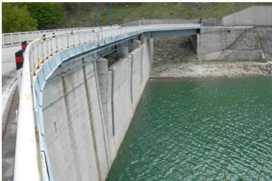
Figura 7: Diga di Rio Fucino – vista da monte
