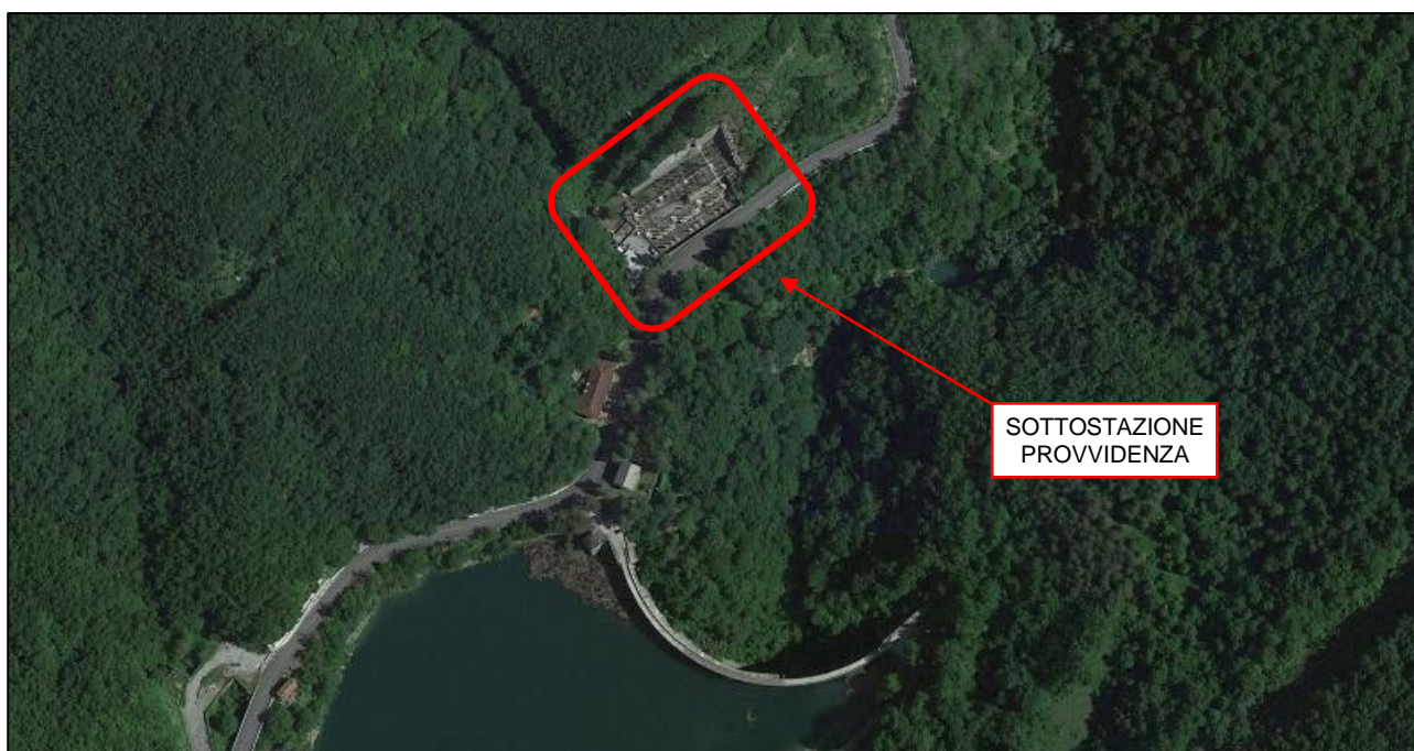
Figura 1: Inquadramento generale sottostazione centrale Provvidenza
