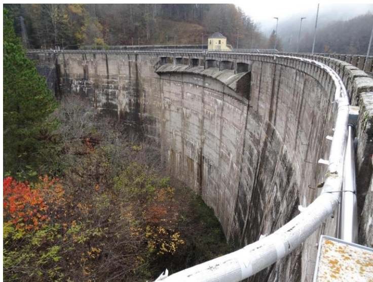
Figura 5: Diga di Provvidenza – vista da valle
