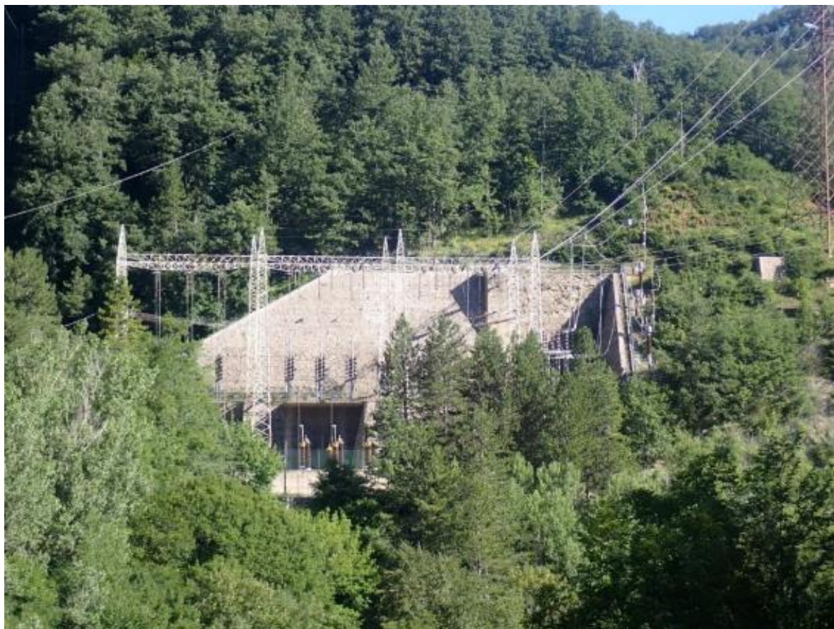
Figura 56: Versante a monte della centrale di Providenza con diffusa presenza di conifere
