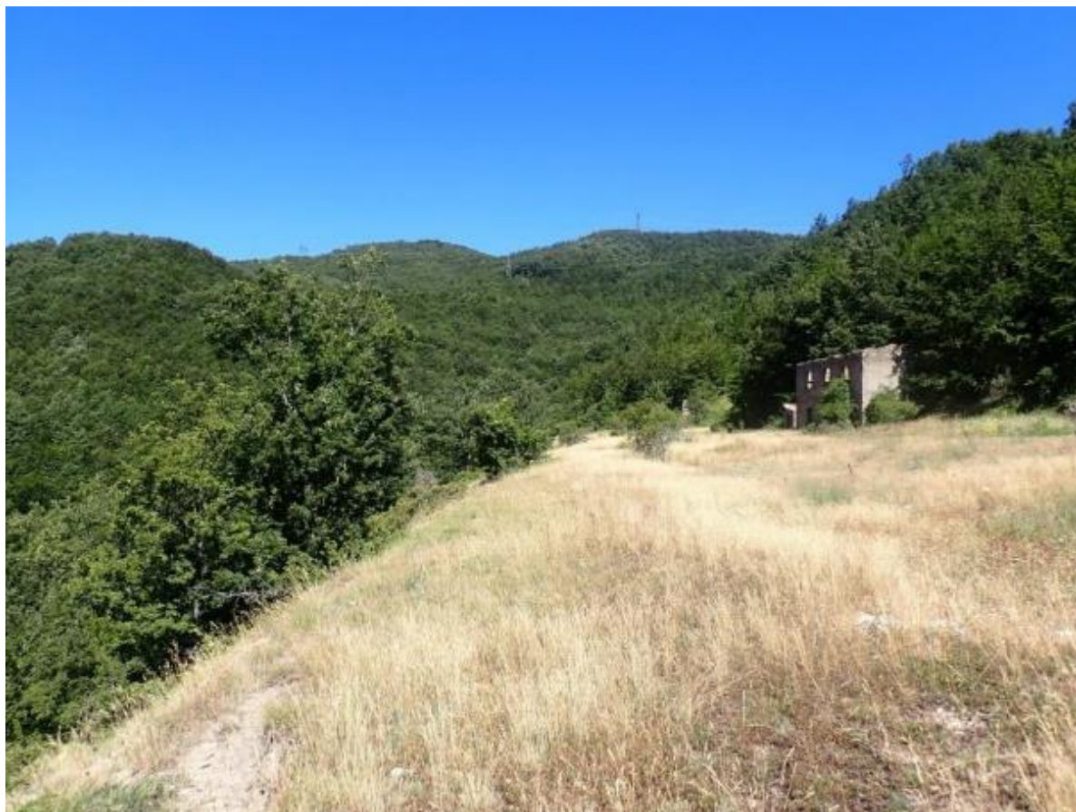
Figura 43: Contesto di intervento lungo il versante del Torrente Provvidenza. Particolare di pianoro realizzato presumibilmente in occasione della realizzazione degli impianti esistenti
