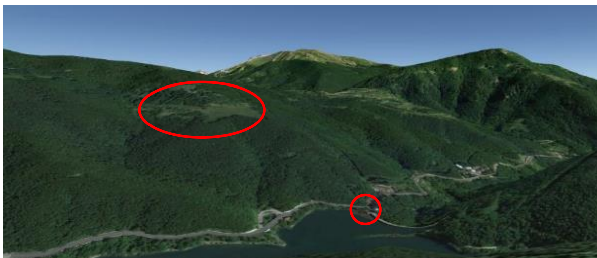
Figura 44: Visuale delle aree di intervento e di cantiere dal versante opposto
