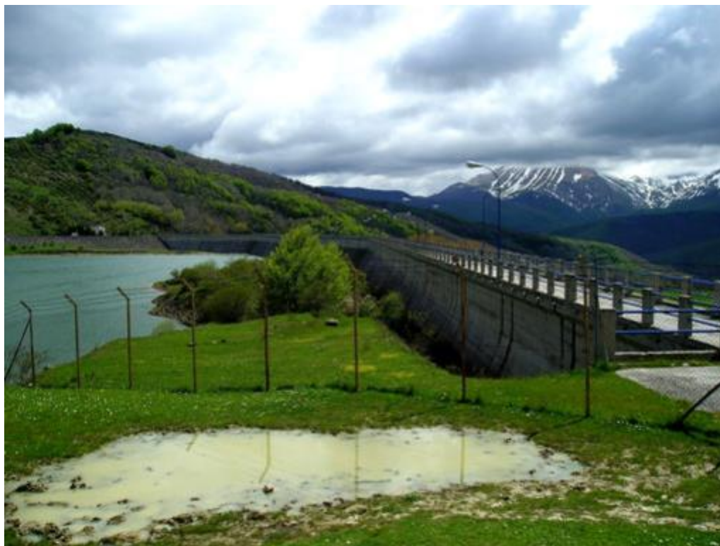
Figura 14: Diga di Sella Pedicate - vista da monte.
