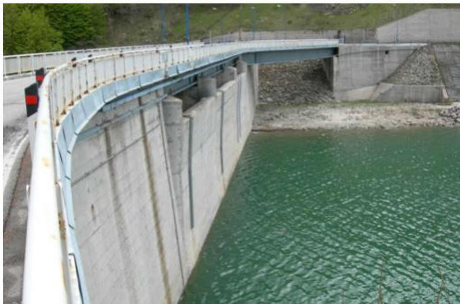
Figura 10: Diga di Rio Fucino – vista da monte.
