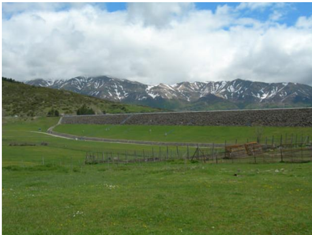
Figura 12: Diga di Poggio Cancelli - vista da valle.
