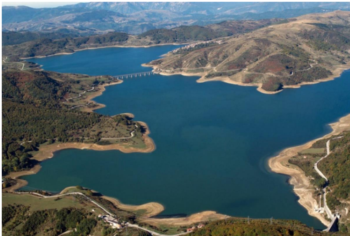
Figura 5: Serbatoio di Campotosto – vista aerea.
