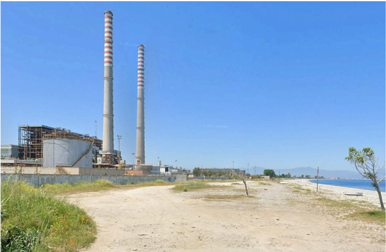
Foto 1 – area punto di giunzione
