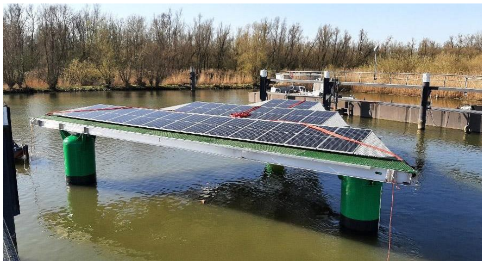
Figura 9 - Triangolo galleggiante (Fonte: https://solarduck.tech )
