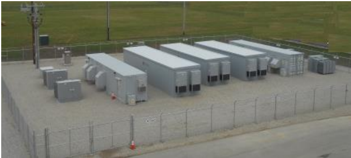
Figura 27 – Sistema tipo area accumulo elettrochimico
