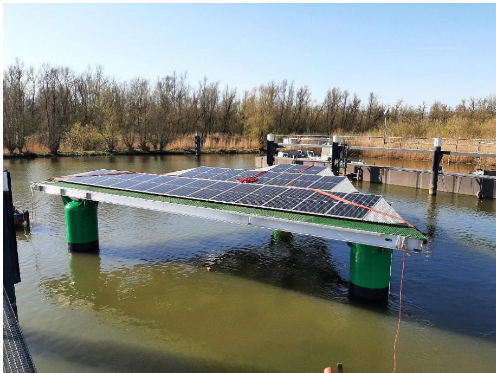
Figura 21 - Esempio di piattaforma triangolare galleggiante per la produzione di energia fotovoltaica (Fonte: https://solarduck.tech )
