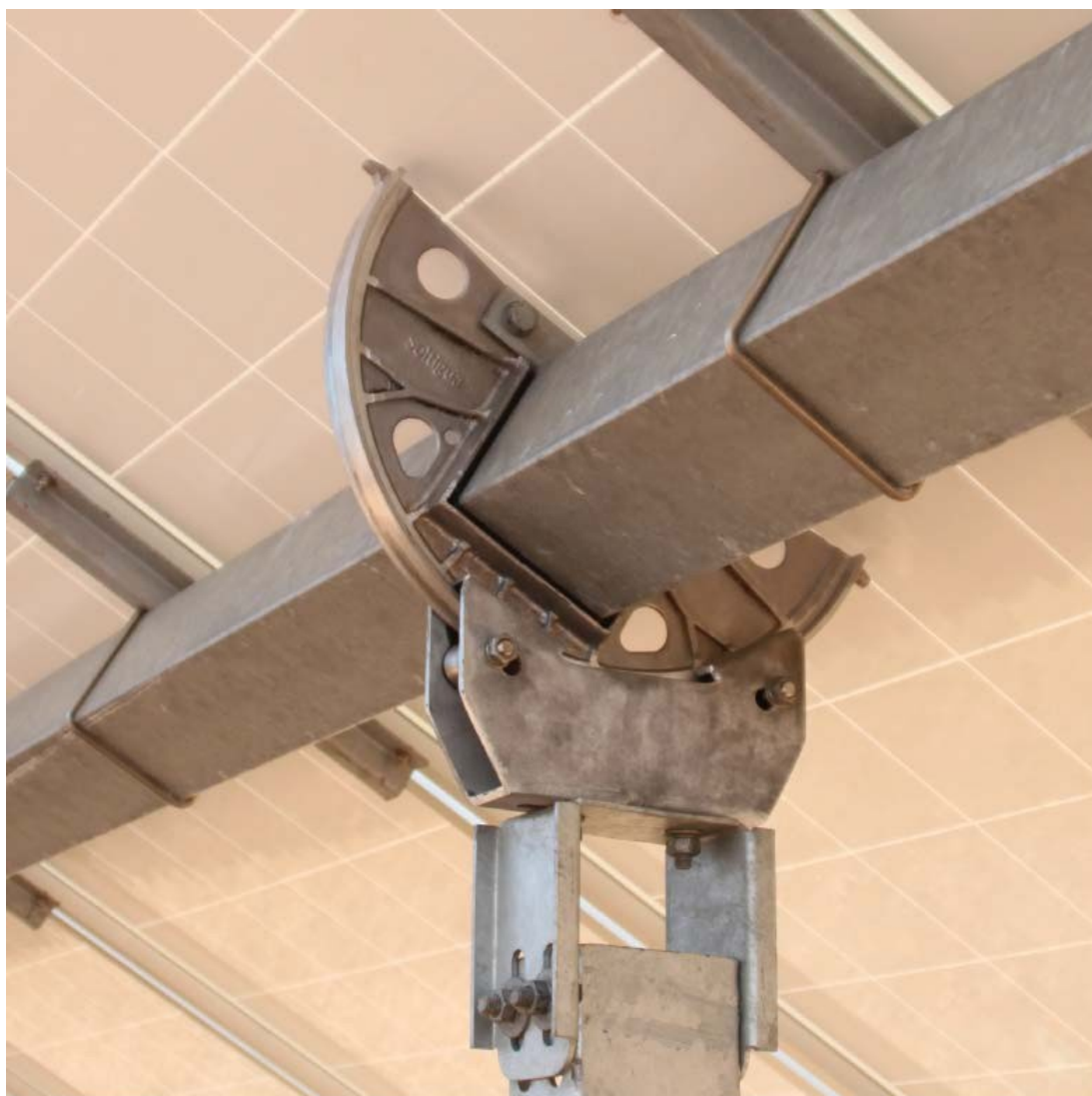
FIGURA 6: SCHEMA NODO TRAVE CONTINUA / COLONNA
