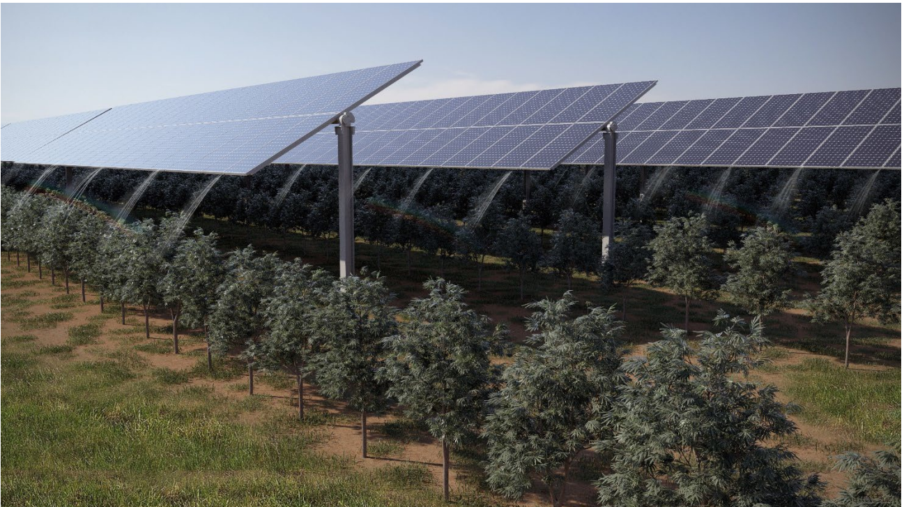
Tipologia impianto agrovoltaiico – Impianto di irrigazione e sensori di campo integrato con la struttura di pertinenza.
