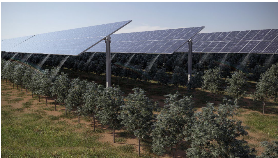
Tipologia di impianto Agrofotovoltaico
