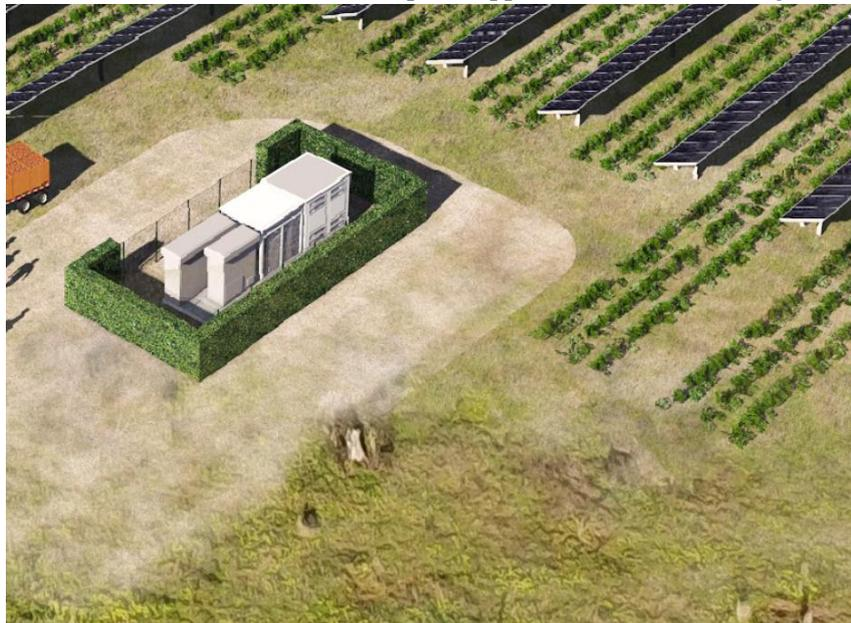
Figura 12: Apparati tecnici inverter e trasformatori di campo
