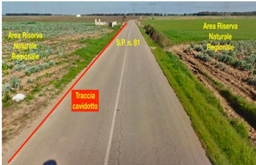
Foto n. 3: vista S.P. 81- tratto in attraversamento Riserva, con cavidotto.
