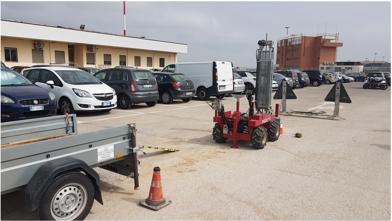
Fig. 1: Particolare esecuzione prova penetrometrica dinamica P1 – parcheggio aerostazione
