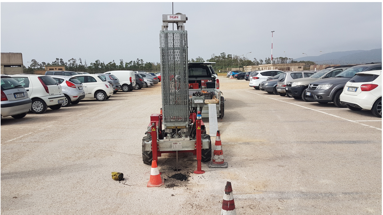
Fig. 2: Particolare esecuzione prova penetrometrica dinamica P1 – parcheggio aerostazione.
