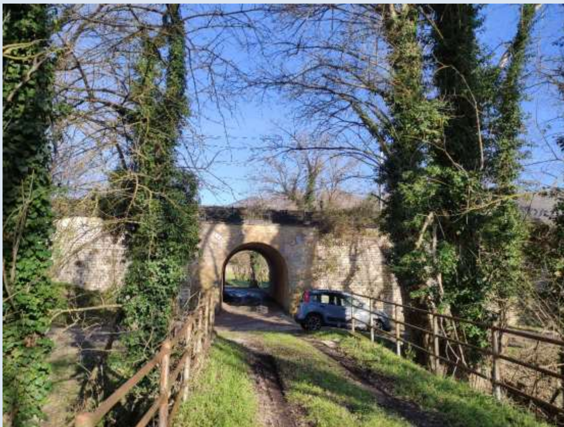
Foto 3 Sottopasso esistente in prossimità dell'abitato di Tiberi e ponte sul torrente Giano
