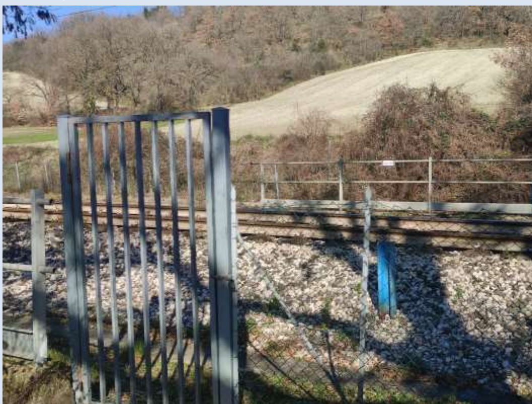
Foto 16 Linea ferroviaria al km 228+780 (in prossimità di uno degli estremi del lotto di intervento)
