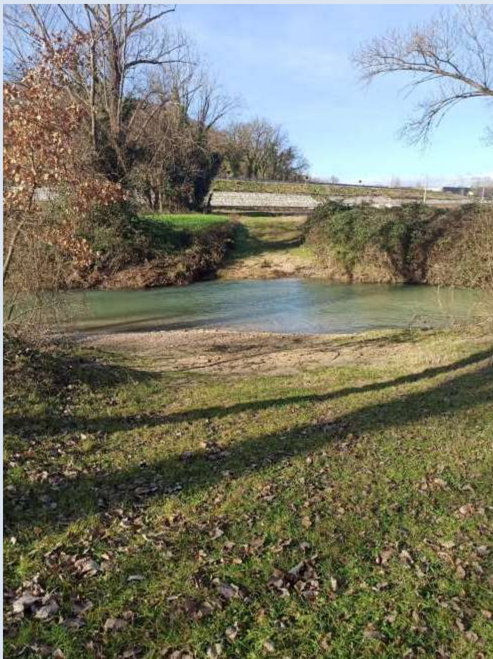
Foto 9 Area del ponte Bailey temporaneo
