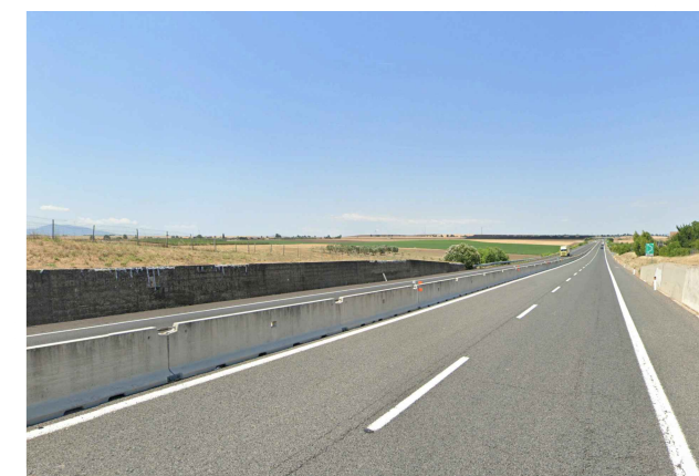
Autostrada 16 - Impianto Visibile
