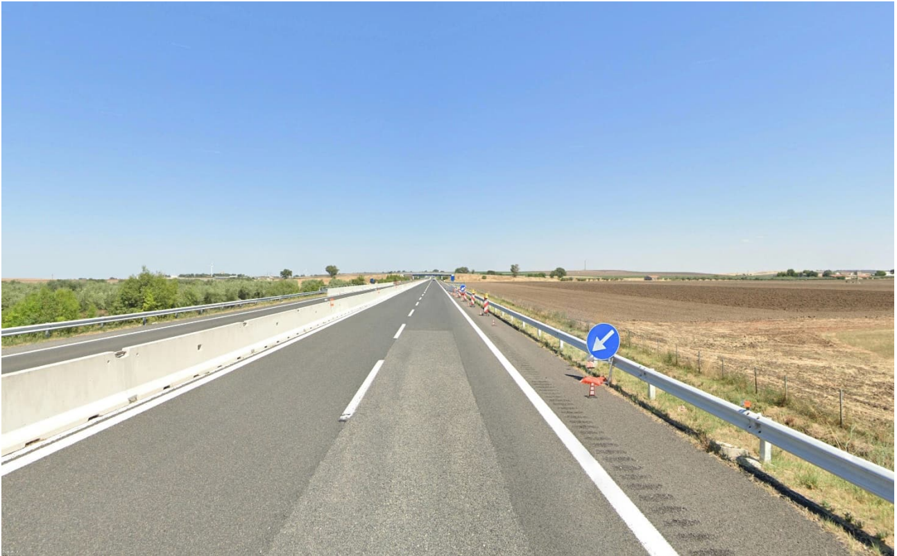
Stato di fatto dal punto di osservazione A
