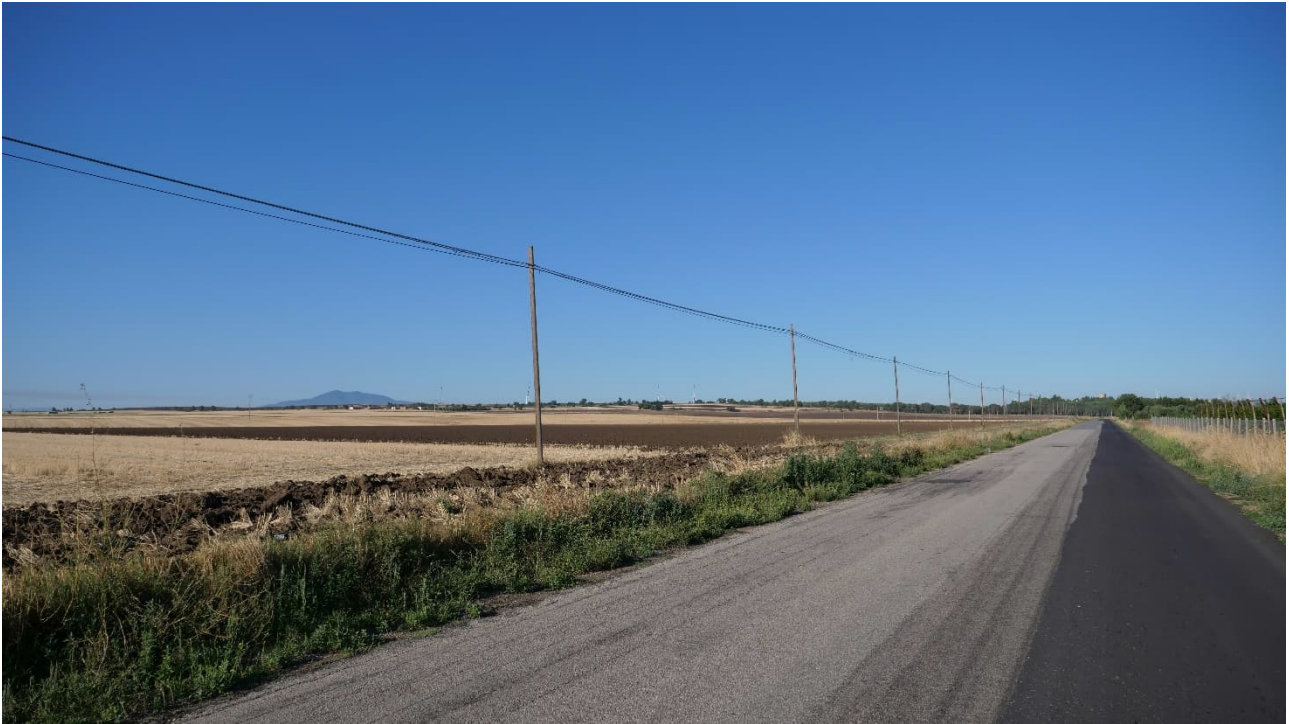
Stato di fatto dal punto di osservazione C
