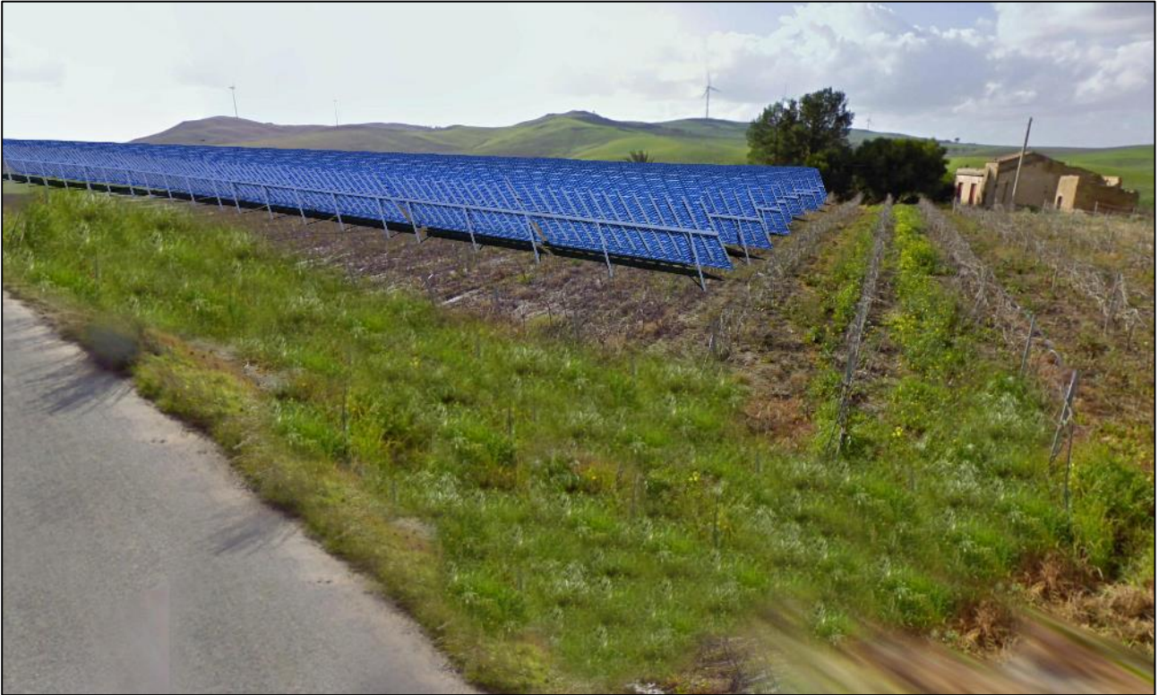
Figura 30 - Impianto ante mitigazione
