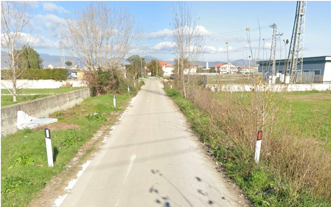
Figura 22 - Foto 31 – Tratto cavidotto su strada asfaltata
