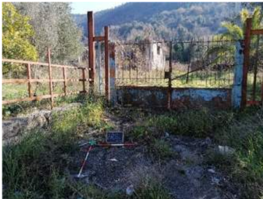
Panoramica area inaccessibile, UR22.
