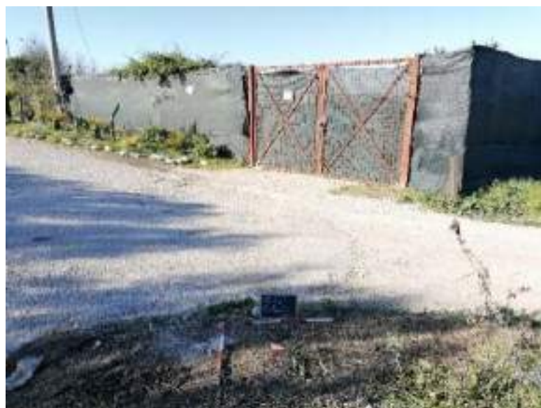
Panoramica area inaccessibile, UR13.
