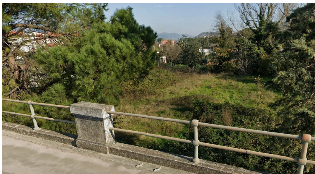
Figura 45: Foto 15 – inquadramento area interessata dalle opere di connessione (elettrdotto aereo)
