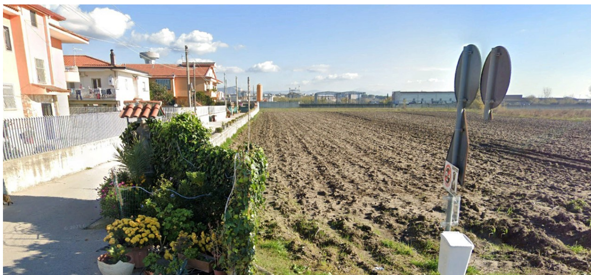
Figura 44: Foto 14 – inquadramento area interessata dalle opere di connessione (elettrdotto aereo)
