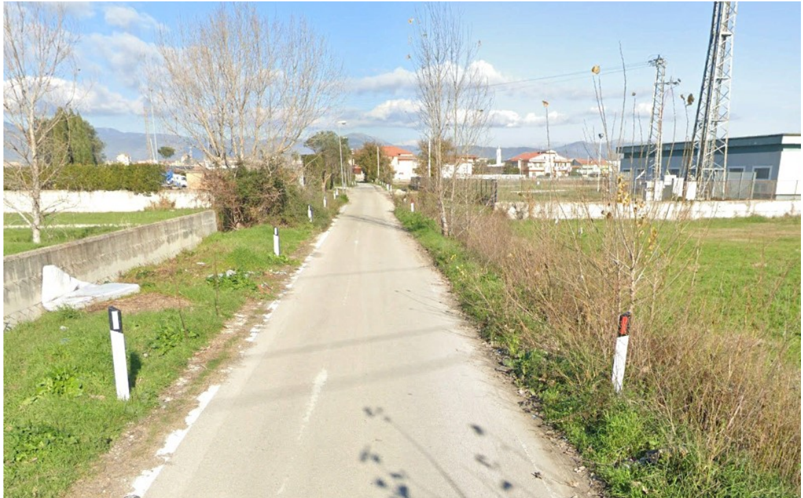
Figura 40: Foto 31 – Tratto cavidotto su strada asfaltata
