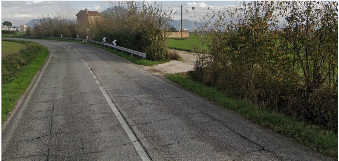
Figura 32: Foto 12 – Accesso all'area di impianto
