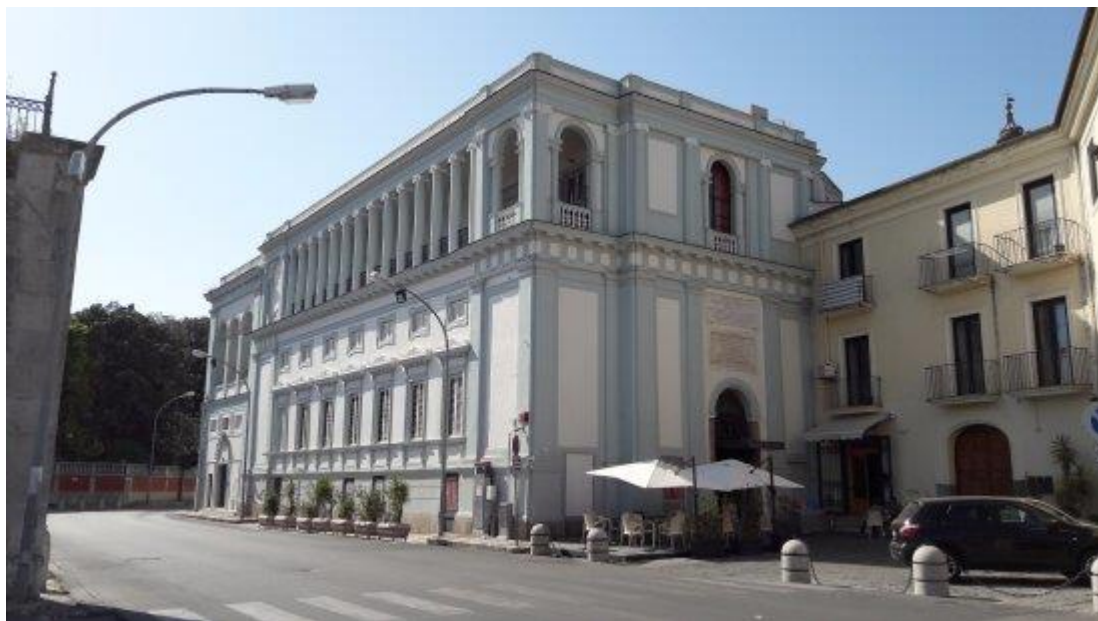
Figura 73: Teatro Ricciardi (Fonte: http://vincolinrete.beniculturali.it/ )
