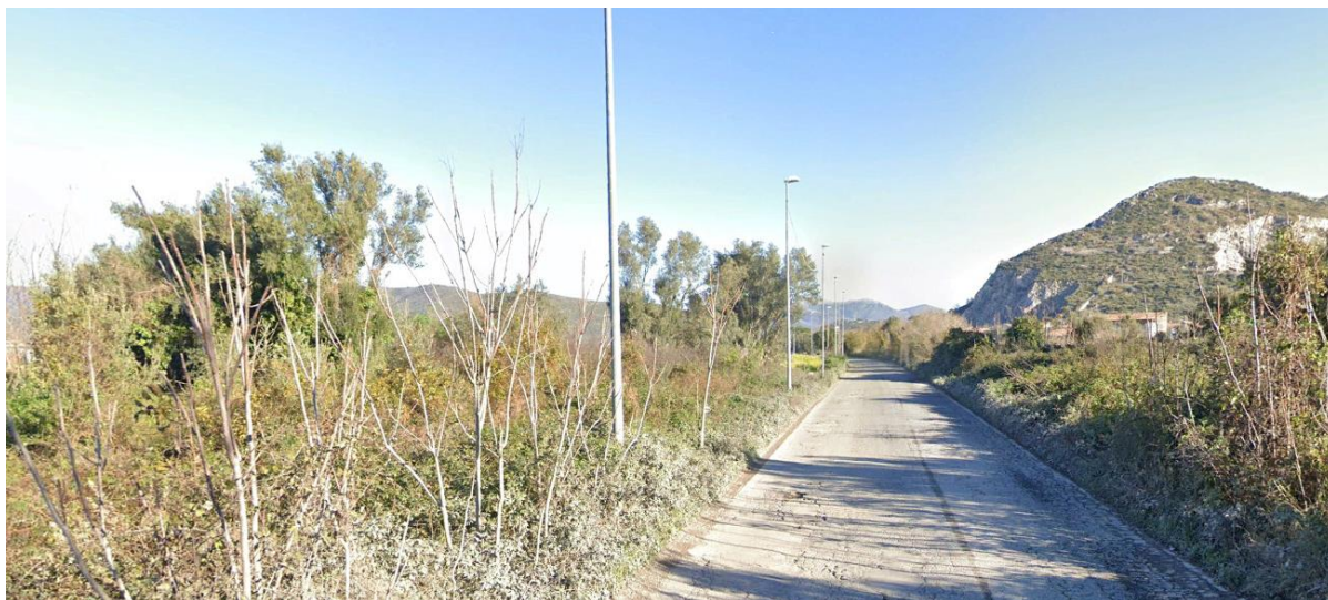
Figura 62: Foto 21 – inquadramento area interessata dalle opere di connessione (elettrodotto aereo)
