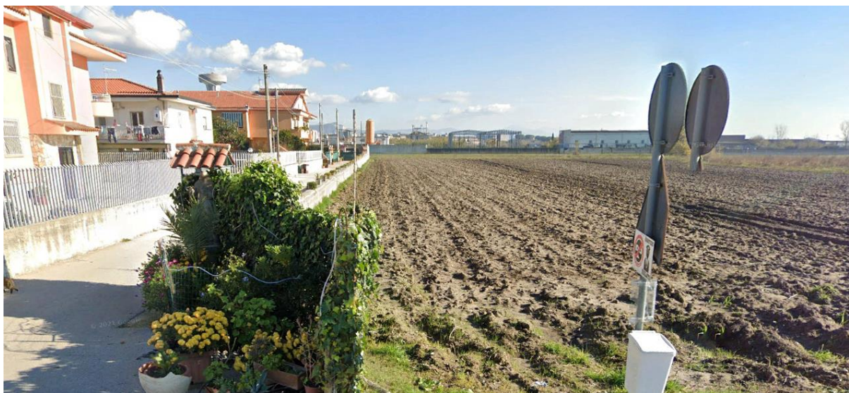
Figura 55: Foto 14 – inquadramento area interessata dalle opere di connessione (elettrodotto aereo)
