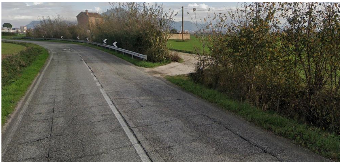
Figura 43: Foto 12 – Accesso all'area di impianto
