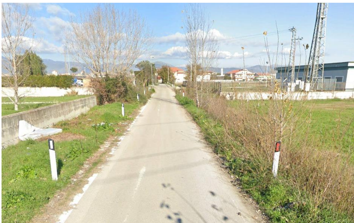
Figura 51: Foto 31 – Tratto cavidotto su strada asfaltata
