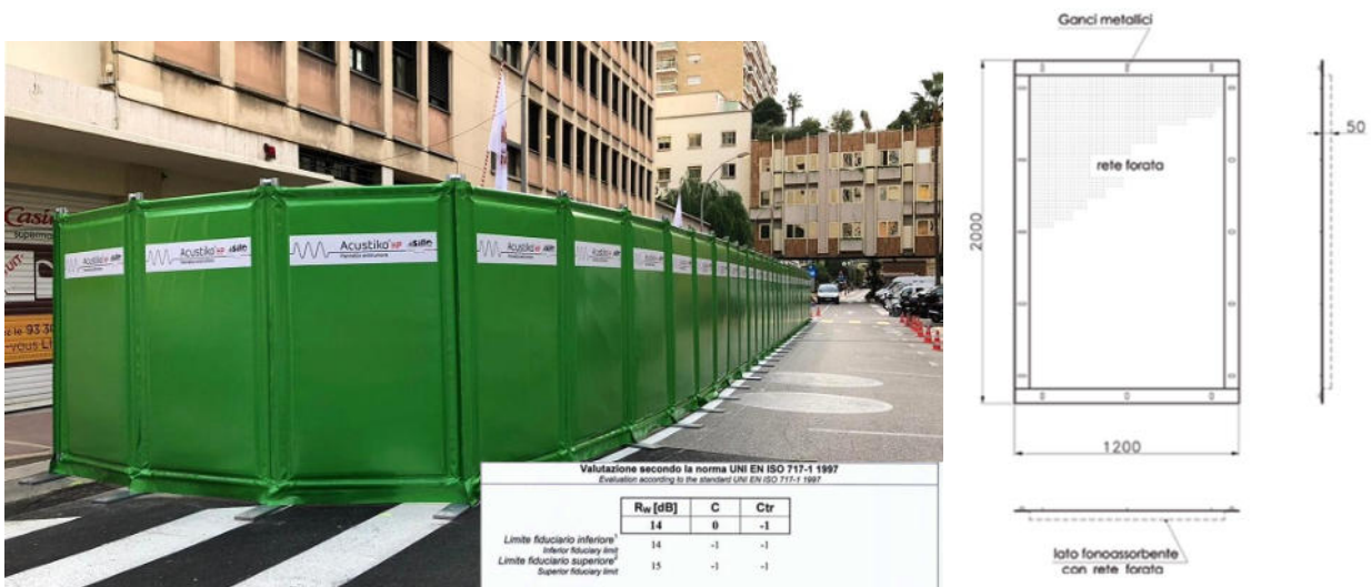
Fig. 15: Caratteristiche tecniche e dati di abbattimento della barriera antirumore temporanea di cantiere
