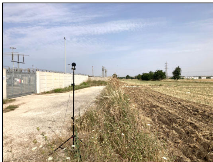
Fig. 11 –Punto di misura C presso SE
