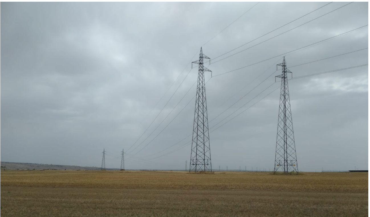
Tralicci che attraversano il sito di progetto "San Francesco", Santeramo in Colle (BA)
